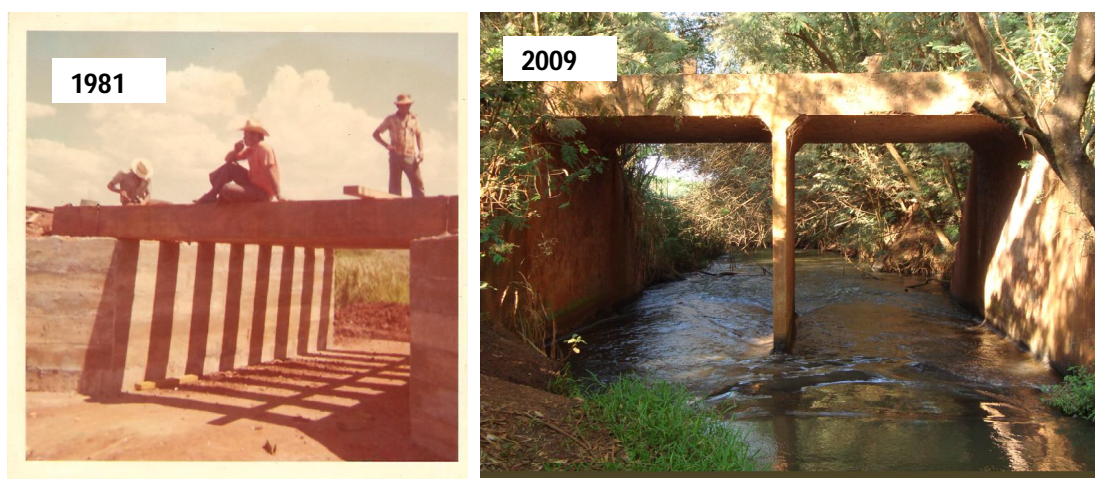
Figura 47: Floresta/ Ponte sobre onde passaria o canal do ribeirão Caxias após o desvio do curso (1981; 2009)
