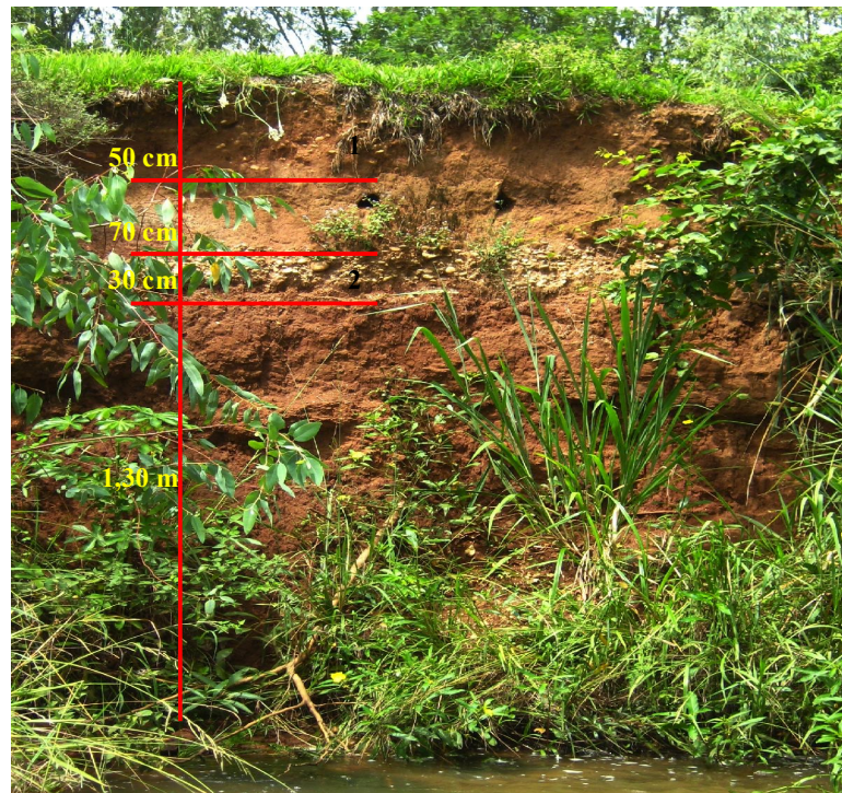
Figura 63: Neossolo Flúvico: Perfil apresentado pela erosão na margem do córrego Água da Marilena. Abaixo de 243 m de altitude encontra-se um perfil de 2,80 m que vem sendo erodido pela ação das intempéries. A área esta localizada próxima a planície de inundação do rio Paranapanema. Este local apresenta vestígios das enchentes ocorridas na região. Em período de cheias do rio Paranapanema a área é alagado e ao mesmo tempo (re) configura o relevo do local, evidenciado a partir do material depositado (seixos) e encontrado na área (indicado pelos nº 1 e 2). Propriedade: Sr. Miguel Tranin.
