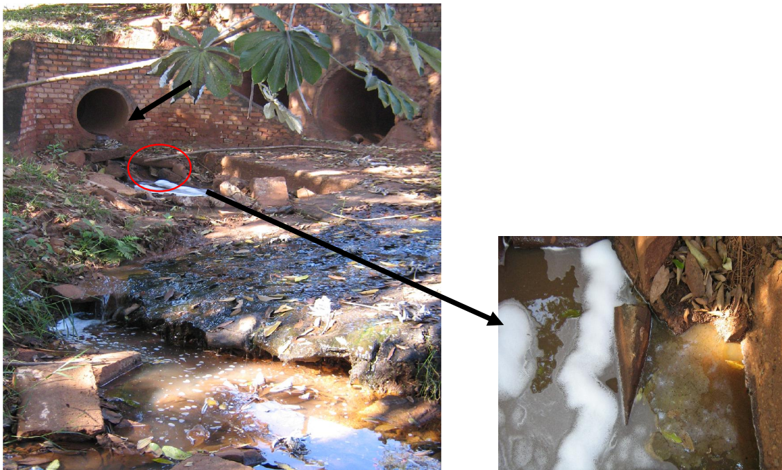
Figura 104: Localizado em área urbanizada, as águas do córrego Água da Marilena, canalizada, (re) inicia seu percurso.
