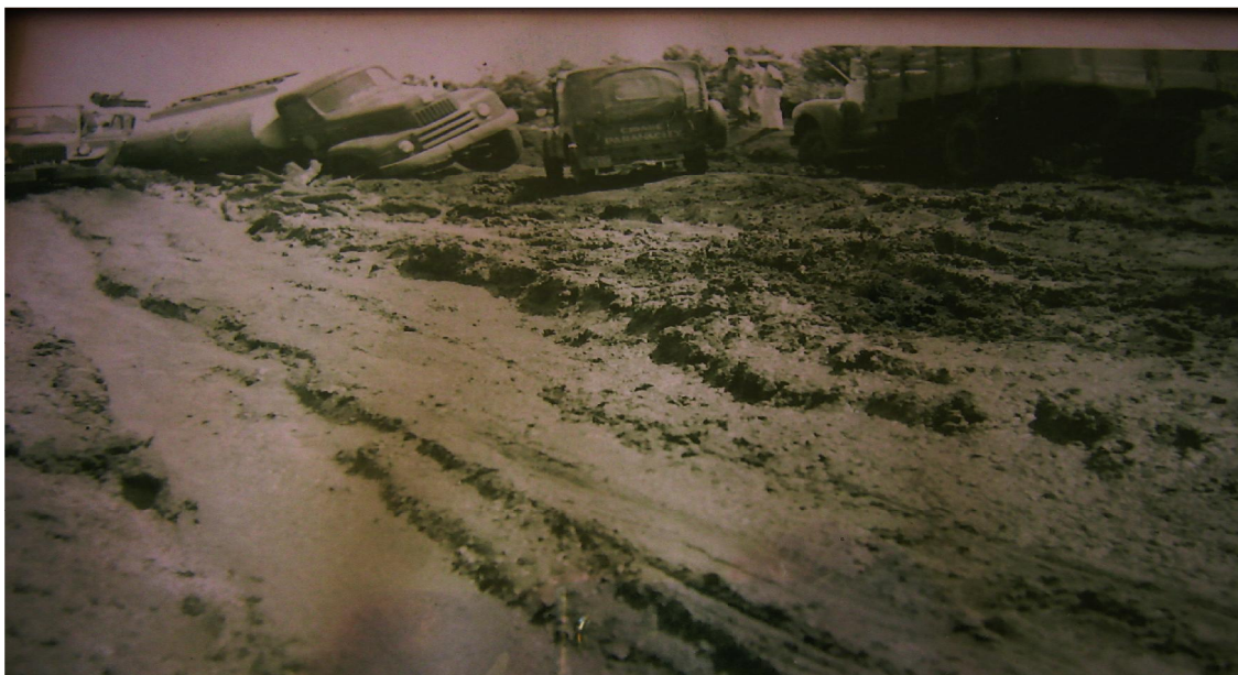
Figura 39: As dificuldades encontradas em algumas épocas do ano – condições das estradas do município após as chuvas, em 1950.
