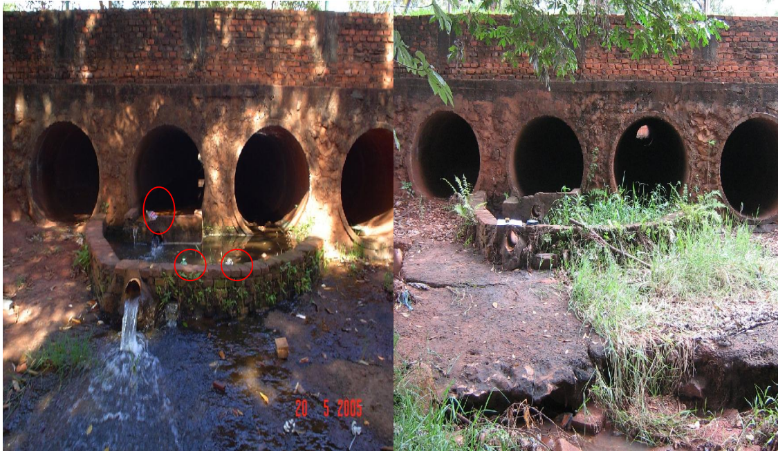
Figura 103: Canalização do córrego Água da Marilena, área de lazer Parque Iracema.
