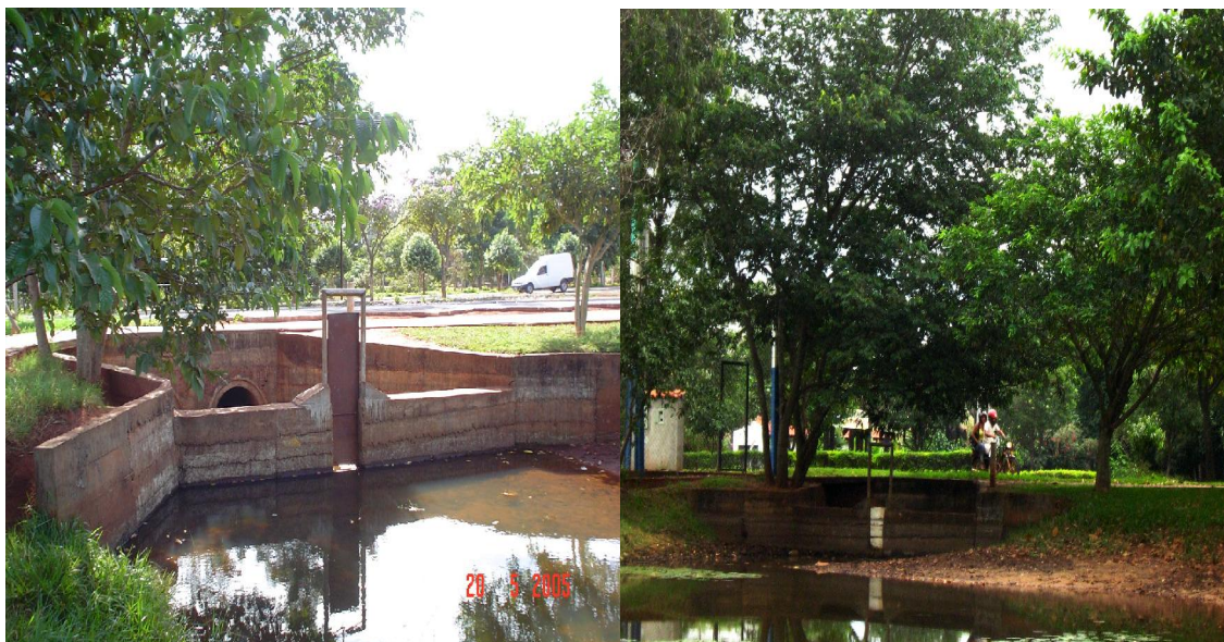
Figura 99: Comparações da paisagem do córrego Água da Marilena (II). Vista no sentido Lago Taboal para a Avenida Paraná, em maio de 2005 e fevereiro de 2009. Verificam-se as transformações desta área, quanto ao recurso água. As diminuições de água neste lago eram percebidas nos períodos de seca, mas até fevereiro de 2009, os níveis de água do córrego água da Marilena, passam a ser mais expressivos, não conseguem atingir a comporta e ir em direção a jusante. Fonte: COSTA, S. B. (Maio/2005, Fevereiro/2009).
