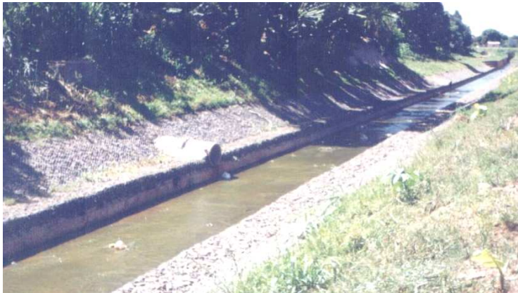
Figura 22: Presença de gabião na parte canalizada do Arroio Schmidt Fonte: Nascimento, P. B. (25/03/2004).
