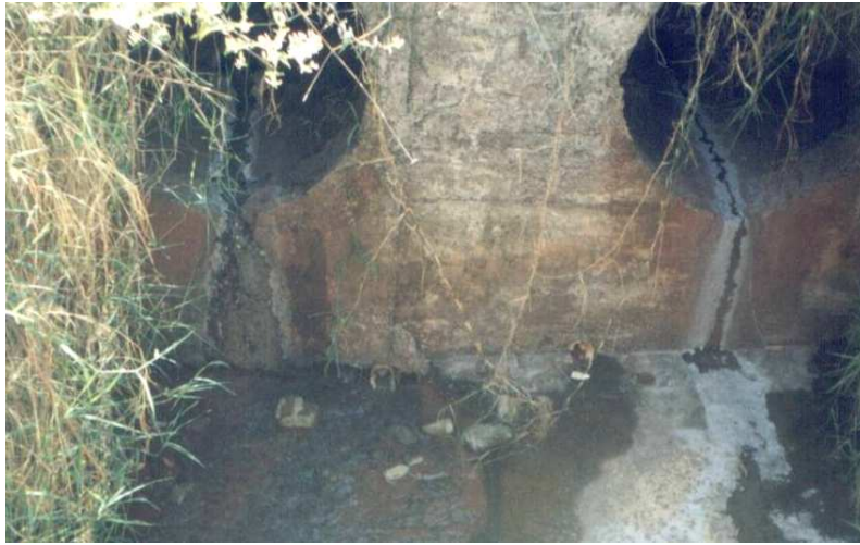
Figura 21: Vista da canalização da nascente do Arroio Schmidt Fonte: Nascimento, P. B. (25/03/2004).
