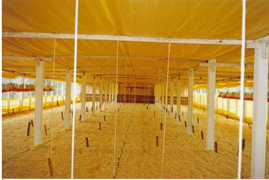
Foto 01 - Aviário destinado para o alojamento de aves.
