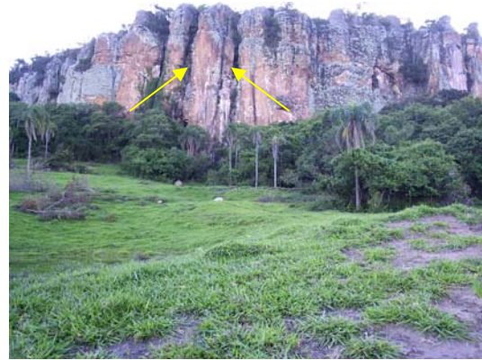
Fig. 12: Morro do Jacaré Separação de blocos
