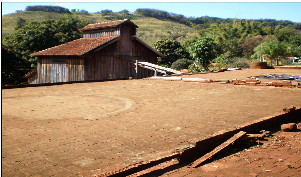
Foto 24 – Instalações cafeeiras da década de 1970 Fonte: Registrado pela autora durante trabalho de campo em 14/07/2007
