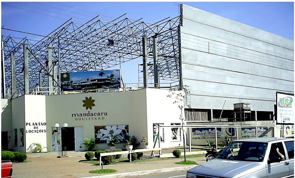
Fotografia 7: Shopping center Mandacaru Boulevard, situado na Avenida Mandacaru, próximo a Avenida Colombo, em construção – JUL. 2007. Fonte: O autor, pesquisa “in loco”, 2007.
