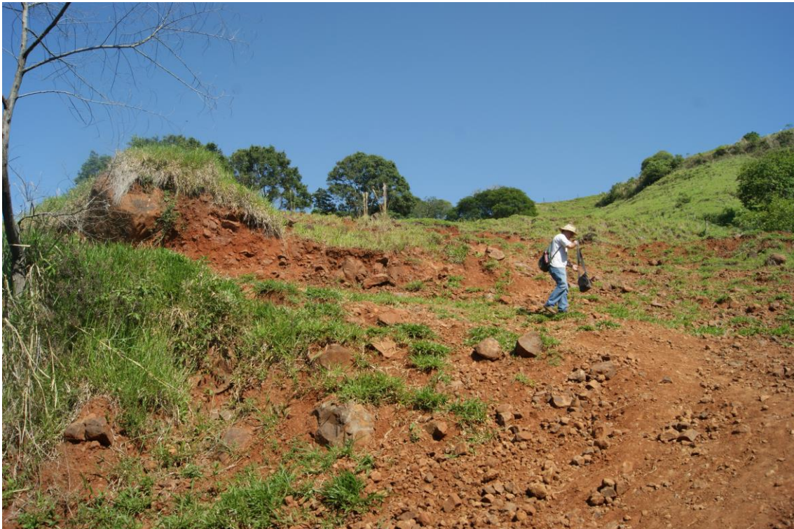
Figura 43: Áreas de risco de deslizamentos com blocos angulosos.
