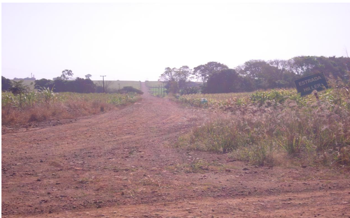
Foto 09 – Estrada Vicinal Hiller
