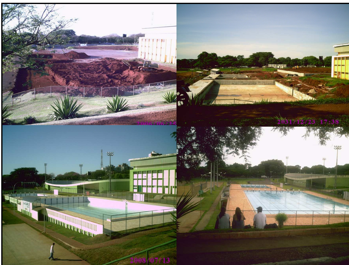
Figura 49: Construção das piscinas olímpicas, de 2006 a 2010. Fotos: Silvio Torrecilha.
