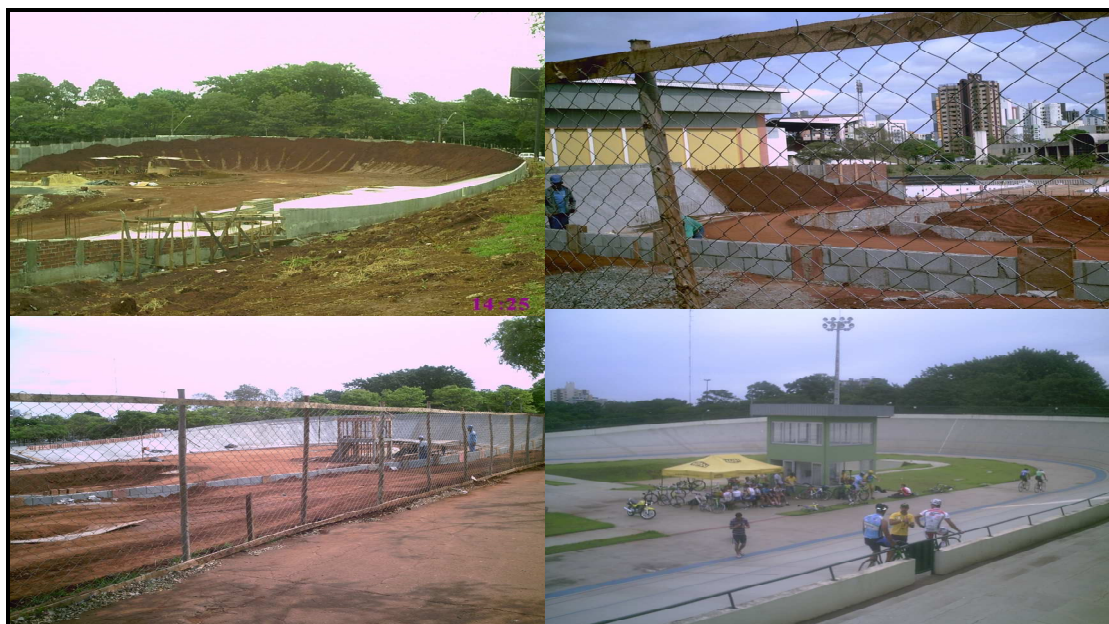
Figura 04: Construção do velódromo na Vila Olímpica de Mgá-Pr. Autor: Silvio Torrecilha (2010).
