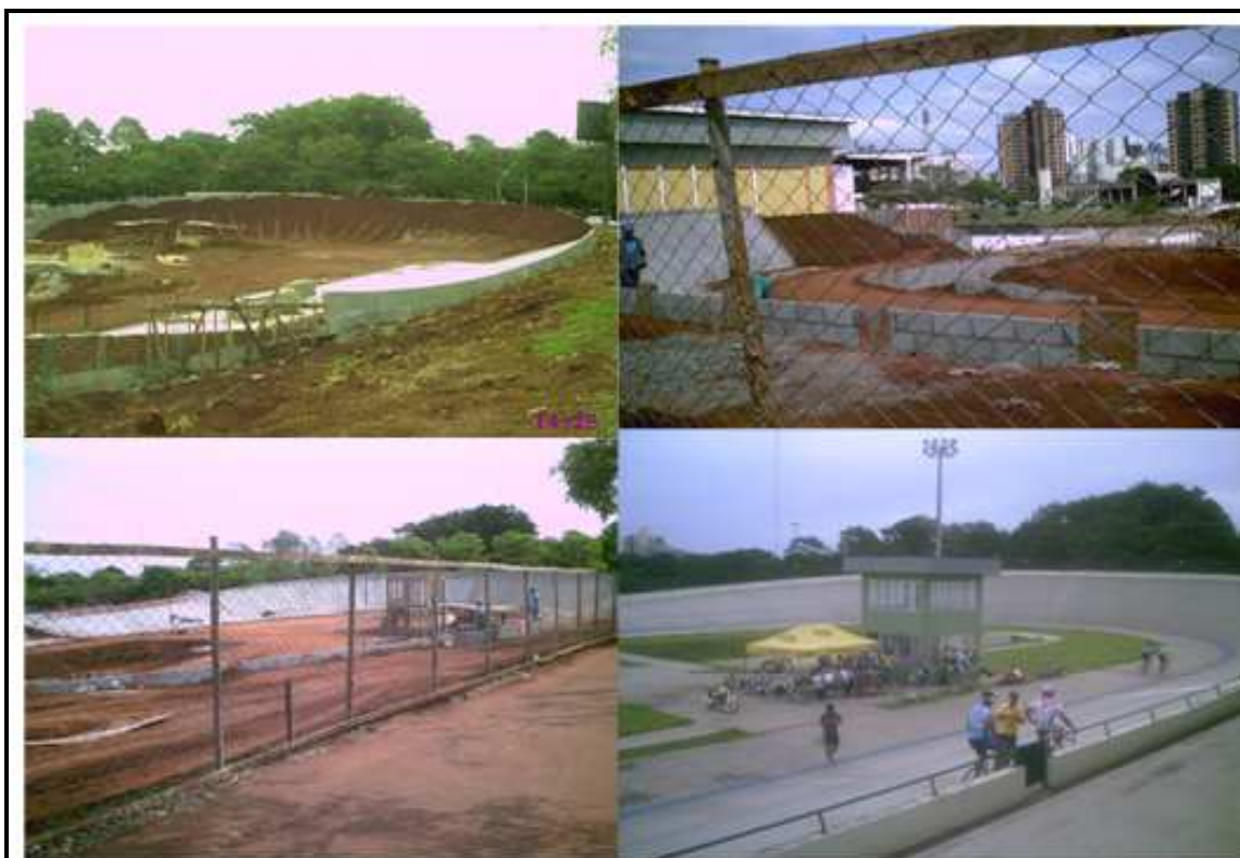
Figura 51: Construção do Velódromo de 2006 a 2010. Fotos: Silvio Torrecilha.
