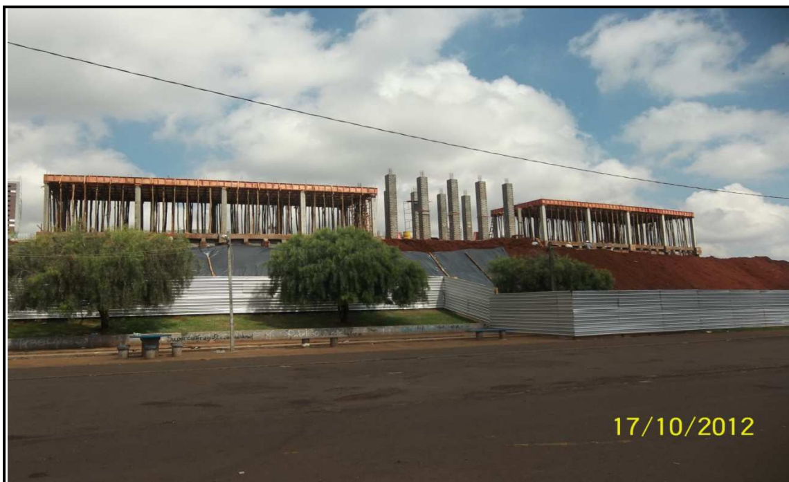
Figura 32: Novo pórtico sendo construído no WD, que abrigará praça de alimentação e sanitários. Foto: Silvio Torrecilha, 2012.
