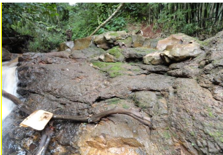
Figura 11: Afloramento do ponto 2 do canal córrego Borba Gato – 21/07/2013 – autor Baggio J.M.
