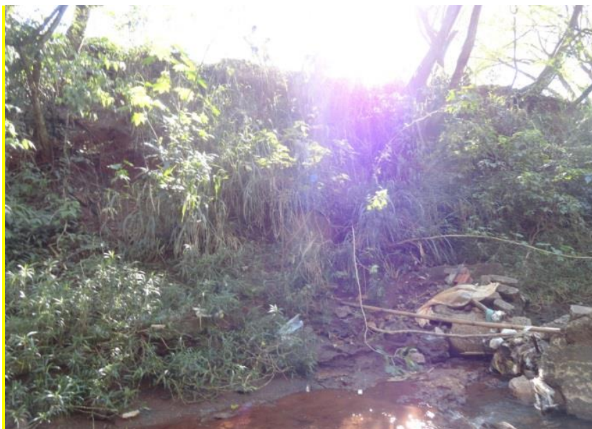
Figura 12: Entulhamento a partir do nível do espelho d'água do ponto 2 do canal do ribeirão Maringá – 14/03/2013 – autor Baggio J.M.
