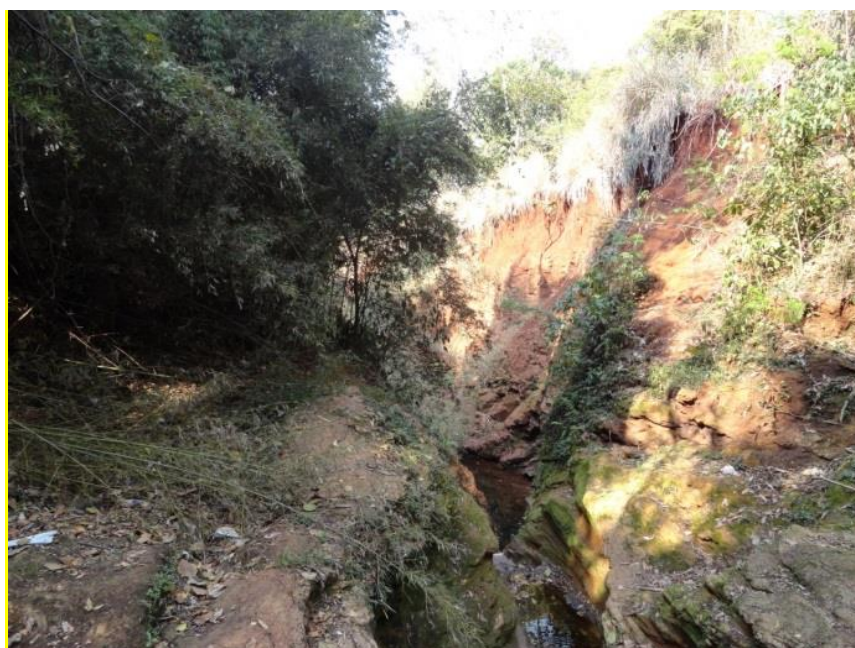
Figura 8: Canal no ponto 2 do córrego Cleópatra – 06/06/2012 – autor Baggio J.M.
