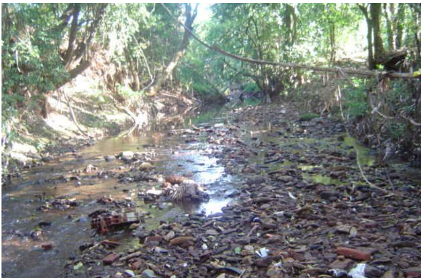
Figura 15: Assoreamento a montante da passagem das ruas e avenidas – autor Baggio J.M
