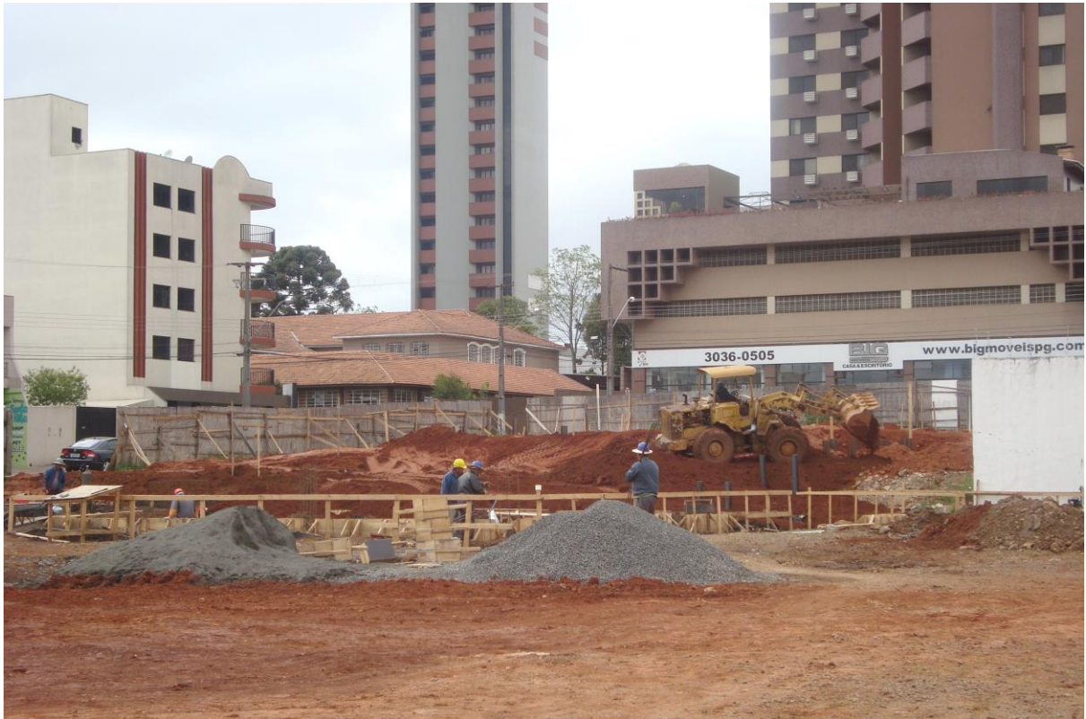
Foto 16: Obra do Teatro e Escola Municipal, vista lateral.
