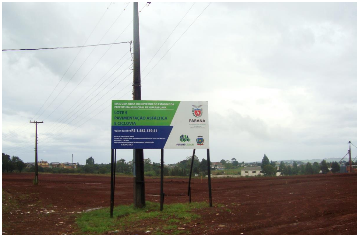
Foto 10: Placa de obra da ciclovia e pavimentação. Local: Guarapuava: Avenida Governador Serafim Ribas Foto: Fachin, Simone C, 2012.
