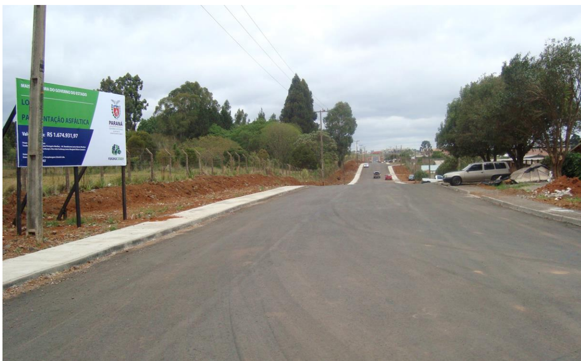
Foto 22: Recapeamento asfáltico no bairro Primavera.
