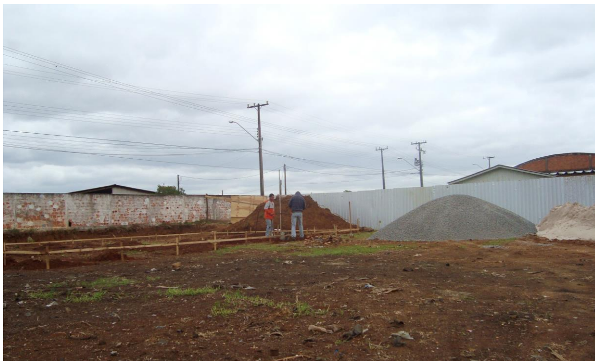
Foto 21: Parte interna da obra da capela mortuária do bairro Primavera
