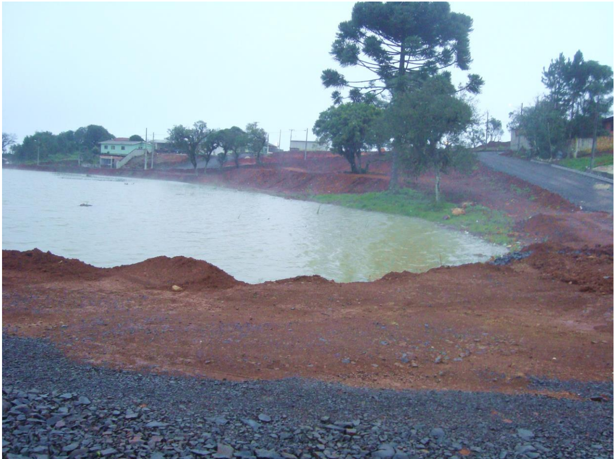
Foto 12: Vista da Lagoa Dourada em processo de reurbanização Local: Guarapuava: Rua Ivaiporã, bairro Boqueirão Foto: Fachin, Simone C, 2012.
