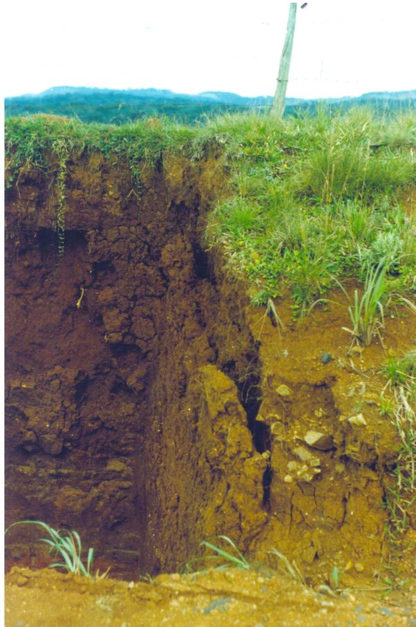
**Figura 72** – Caixa de retenção de sedimentos e fluxo d'água na lateral de estrada da área de estudo. Após contração da argila, ocorre o desprendimento e queda partes da parede da caixa, como o observado nesta foto, provocando o seu entulhamento.
