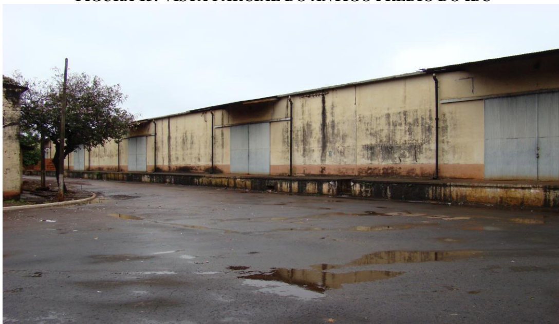
FIGURA 15: VISTA PARCIAL DO ANTIGO PRÉDIO DO IBC
