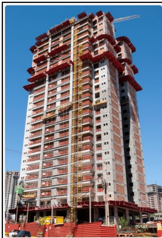
Foto 23: Vista do Edifício Authentique em fase de construção. O edifício terá 23 pavimentos com 4 apartamentos por andar. É qualificado como luxuoso pela localização próximo à Praça Pé Vermelho, pela qualidade dos acabamentos e pelas novas tecnologias de automação utilizadas em sua construção. Fonte: Plaenge (acesso em fevereiro de 2013).
