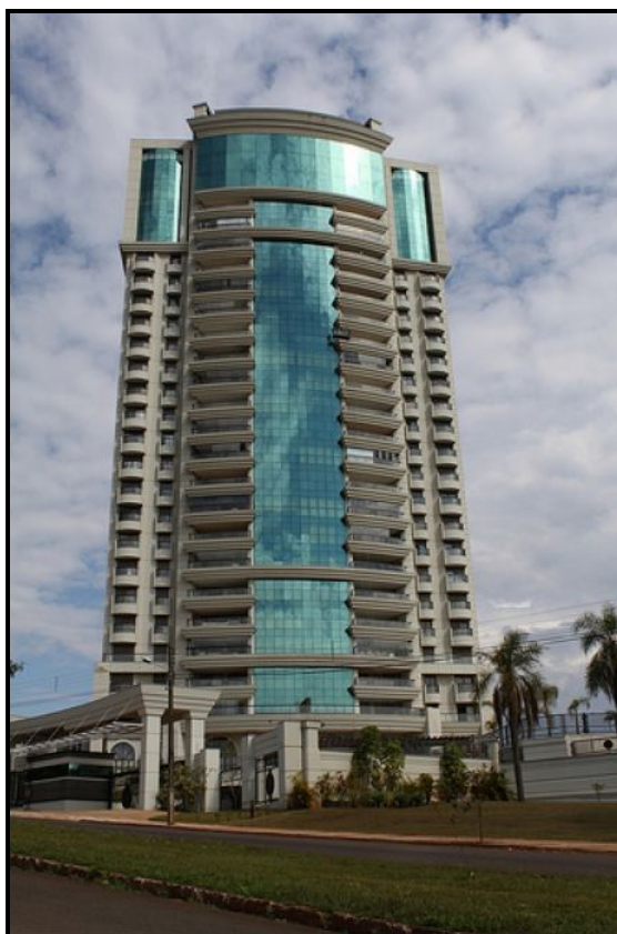
Foto 26: Edifício Palazzo Veronesi situado no Jardim Bela Suíça tendo como proximidades o Lago Igapó. Possui uma estrutura de lazer com quadras, piscinas externas e aquecidas, sauna, playground, horta, pista de caminhada, academia, capela, espaço gourmet e churrasqueira. Fonte: Santos (2013)
