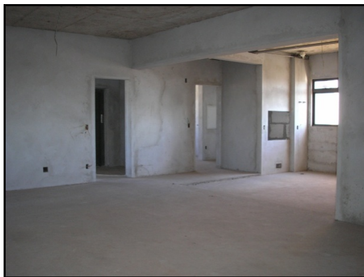
Foto 37: Vista dos ambientes internos ainda sem acabamento. O apartamento é amplo com 4 suítes, 7 ambientes, 4 serviços além de uma enorme sacada que envolve todo o apartamento. Fonte: Santos (2013).
