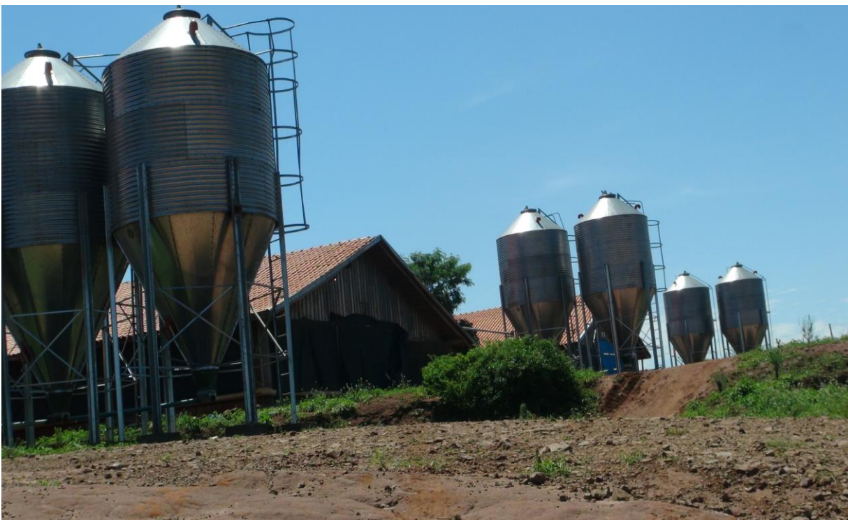
FOTO 4 – VISTA PARCIAL DE PARTE DA ESTRUTURA ARMAZENAMENTO DE RAÇÃO PARA AVICULTURA NO MUNICÍPIO DE ARARUNA.
