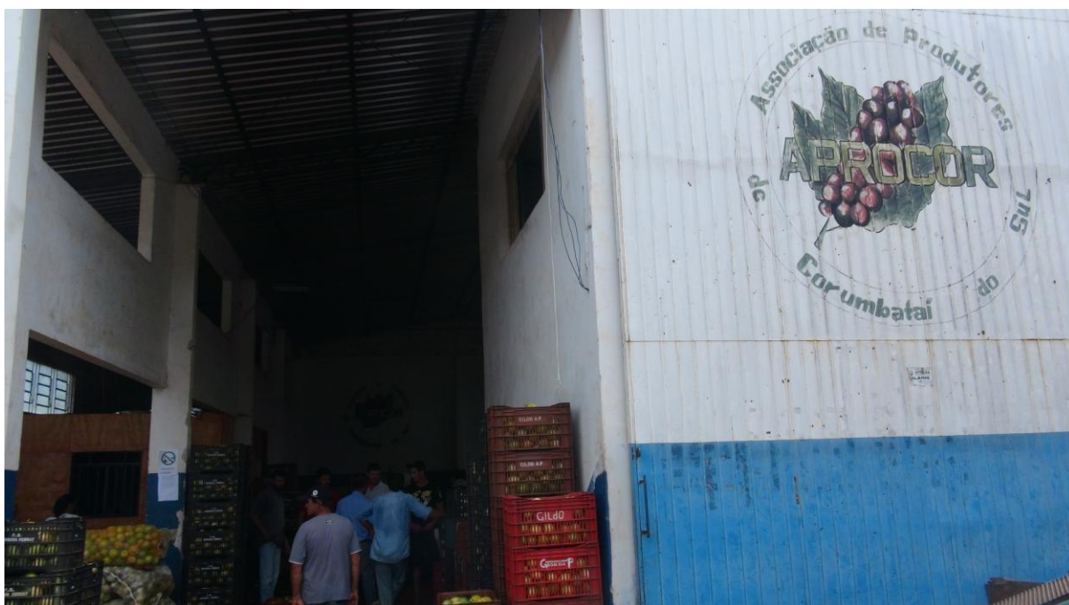
FOTO 7 – VISTA PARCIAL DAS INSTALAÇÕES DA APROCOR/COAPROCOR Fonte: Acervo do Autor, 2012.
