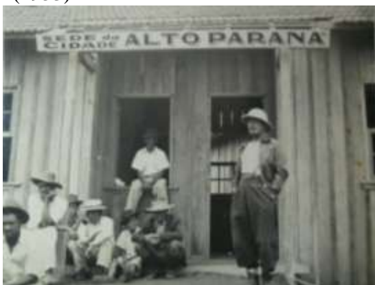
Figura 18 – Escritório sede da CODAL (1953) 79
