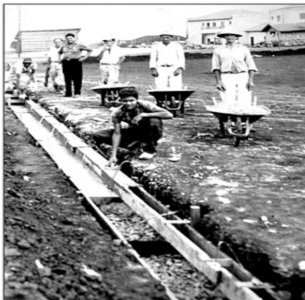
Figura 47 – Aspecto geral das obras que estabeleceram os limites da Praça Aldevino Santiago, no início dos anos 1960.
