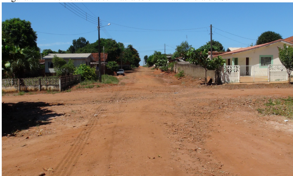
Figura 7 - Avenida e rua sem asfalto em Brasilândia do Sul
