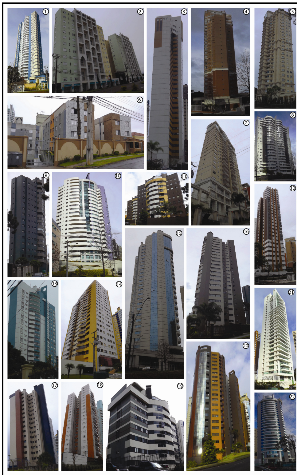
Figura 13: Verticalização no Bairro Ecoville , Curitiba (PR)
