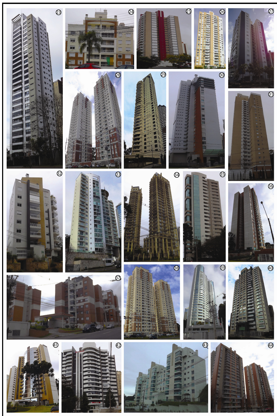
Figura 14: Verticalização no Bairro Ecoville, Curitiba (PR)
