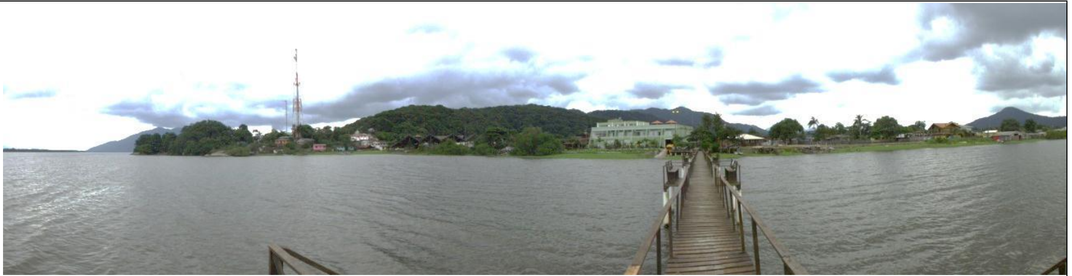
Figura 47. Vista do final do Trapiche, Cerquinho e Ponta do Morretes em conjunto. SOUZA, R.M. (jan. 2013)
