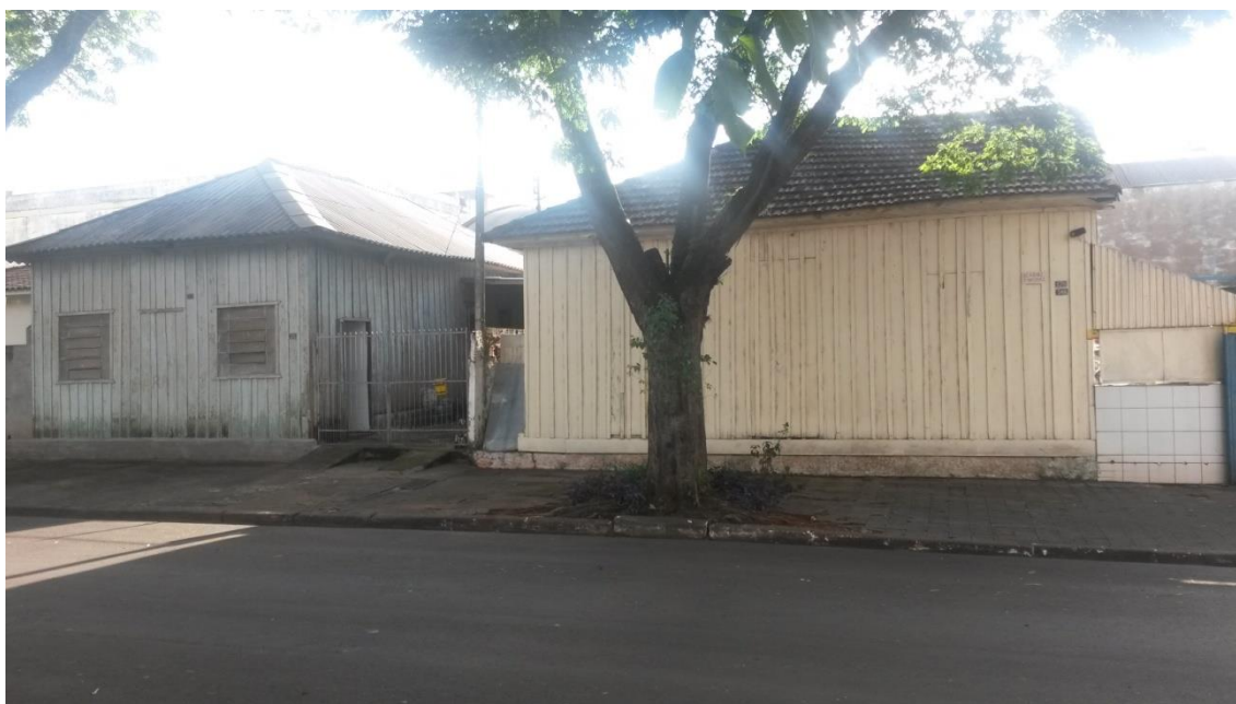
Figura 18: Construções às margens da calçada, na Zona 6, fora dos parâmetros da primeira legislação urbanística aprovada em Maringá (PR)
