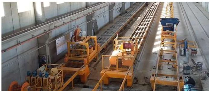
Figura 2.11 – Pista de protensão.
