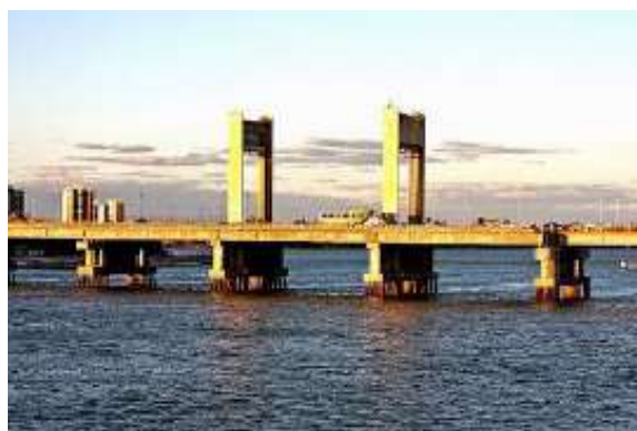
Figura 2.6 – Ponte do Juazeiro – Bahia – Brasil.
