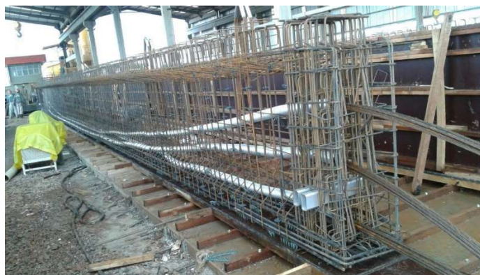
Figura 2.15 – Sistema de Pós-Tensão Aderente.
