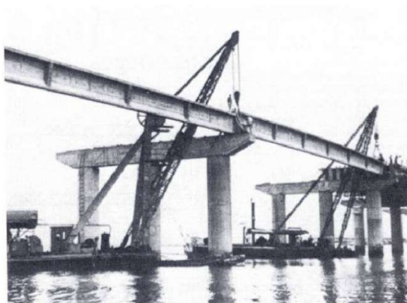
Figura 2.5 – Ponte do Galeão – Rio de Janeiro – Brasil.
