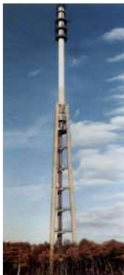
Figura 2.9 – Torre de Telecomunicações Namur – Bélgica.
