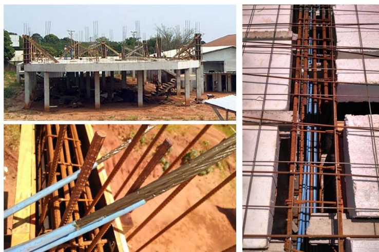
Figura 2.14 – Bloco de salas de aula CAU – UEM – Umuarama – PR.
