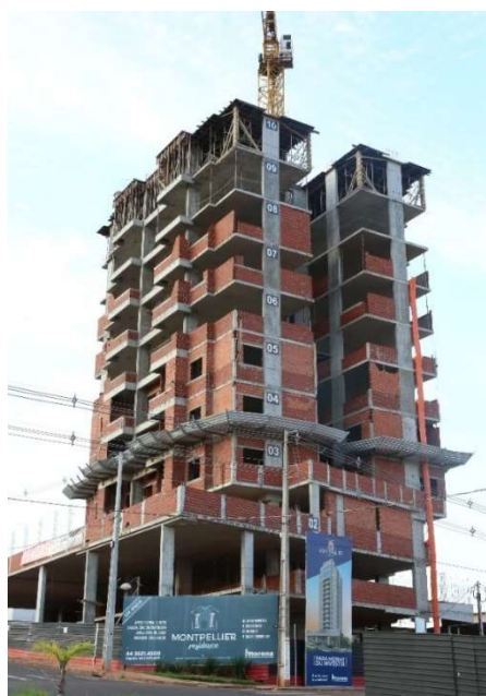
Figura 2.12 – Edifício residencial com Lajes Lisas Protendidas.
