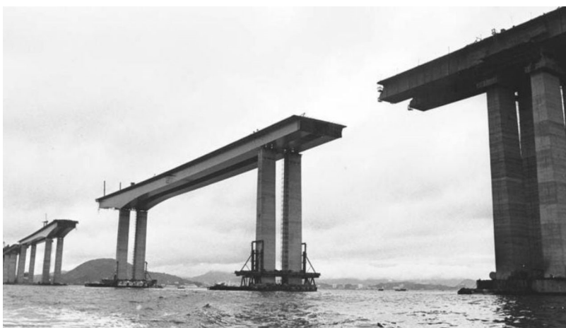
Figura 2.7 – Ponte Rio-Niterói – Rio de Janeiro – Brasil.
