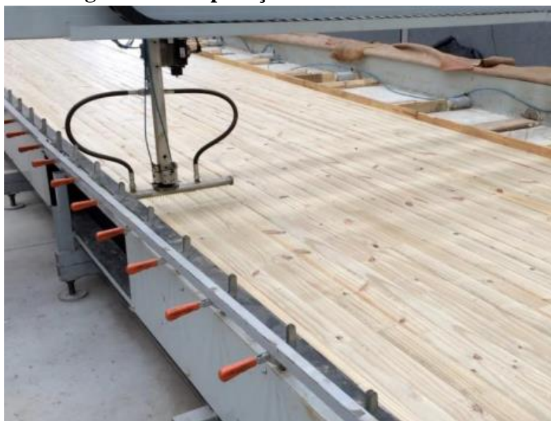
Figura 2.20 - Aplicação do adesivo estrutural
