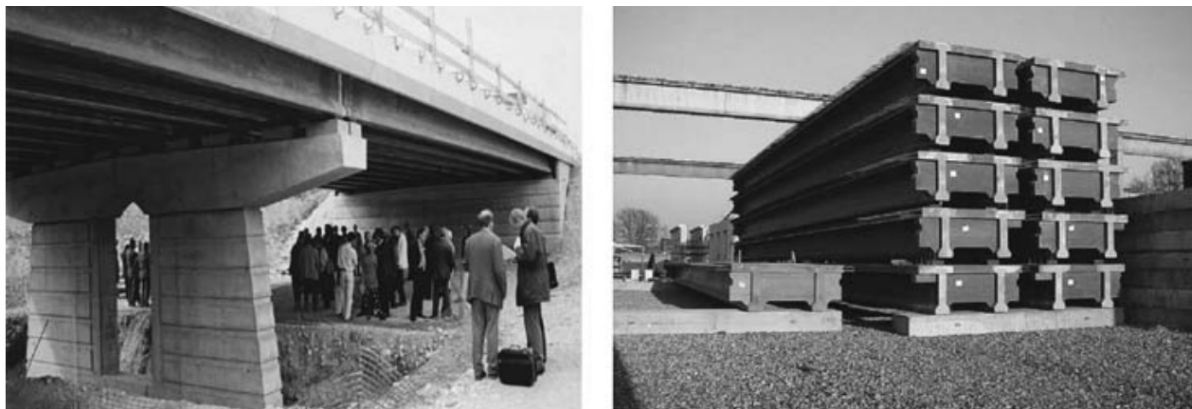
Figura 2.2 – Ponte em UHPC com vigas duplo T protendidas em Bourg-Lès-Valence – França
