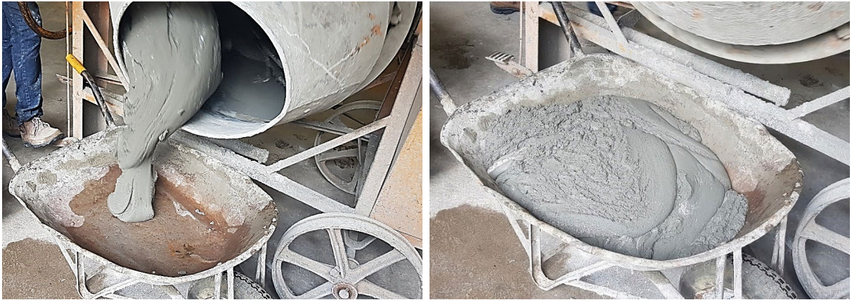
(k) Consistência desejada do UHPC
