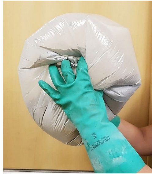
Figura 3.7 – Mistura manual dos materiais secos
