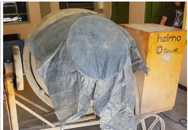
(b) Vedação da betoneira com lona plástica
