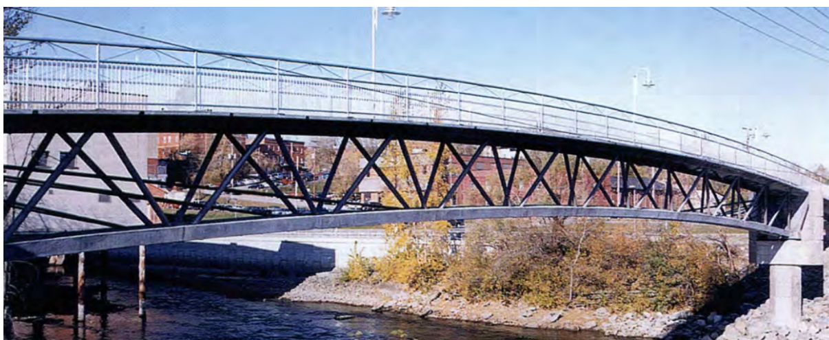
Figura 2.1 – Passarela em UHPC em Sherbrooke Quebec – Canadá (1997)
