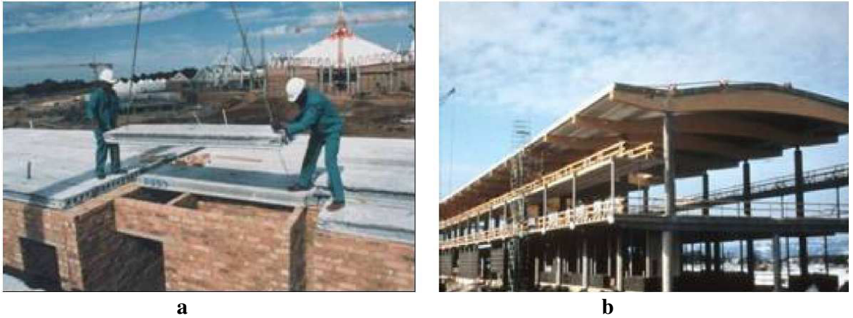
Figura 2.3: a: Lajes alveolares sobre alvenaria estrutural (África do Sul, 2001); b: Lajes alveolares sobre estrutura de madeira (Finlândia, 2005)
