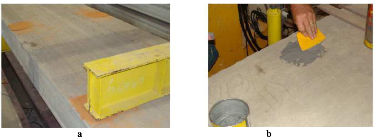
Figura 3.4: Regularização da superfície das lajes na região de contato com a viga de transmissão. A: com areia úmida. B: com massa plástica
