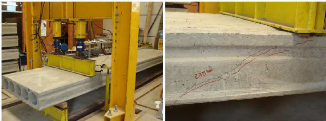
Figura 3.16: Laje LA06 e sua ruptura
