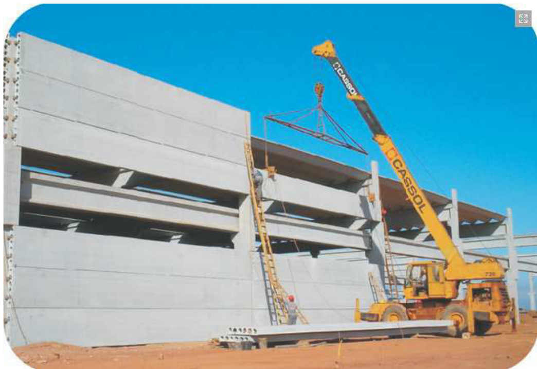
Figura 2.4: Paredes estruturais alveolares
