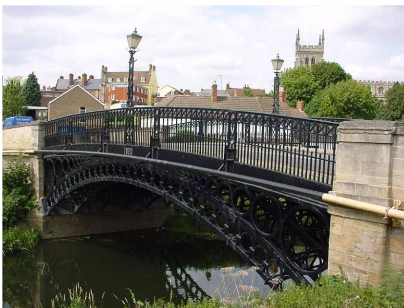
Figura 1.1 - Ponte de Tickford, Reino Unido
