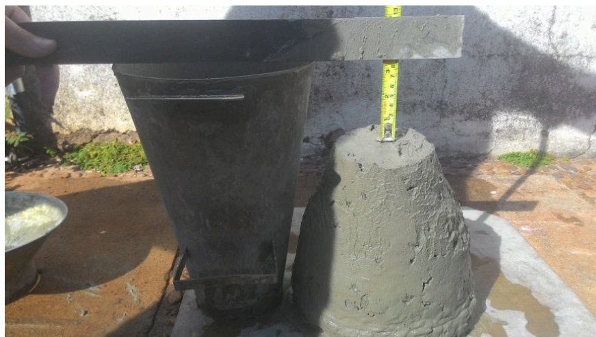
Figura 5.7 – Realização do ensaio de abatimento de tronco
