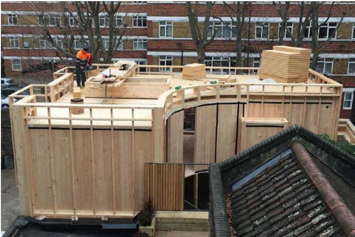
Figura 2.5 – Carmathen House (construção) – Aplicação da MLCC em edificação residencial
