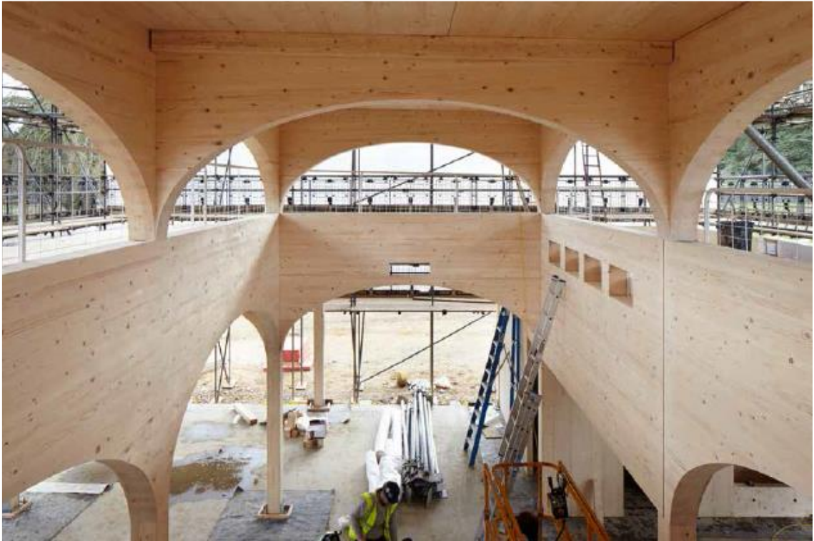
Figura 2.6 – Wilderness Restaurant (construção) – Aplicação da MLCC em edificação comercial
