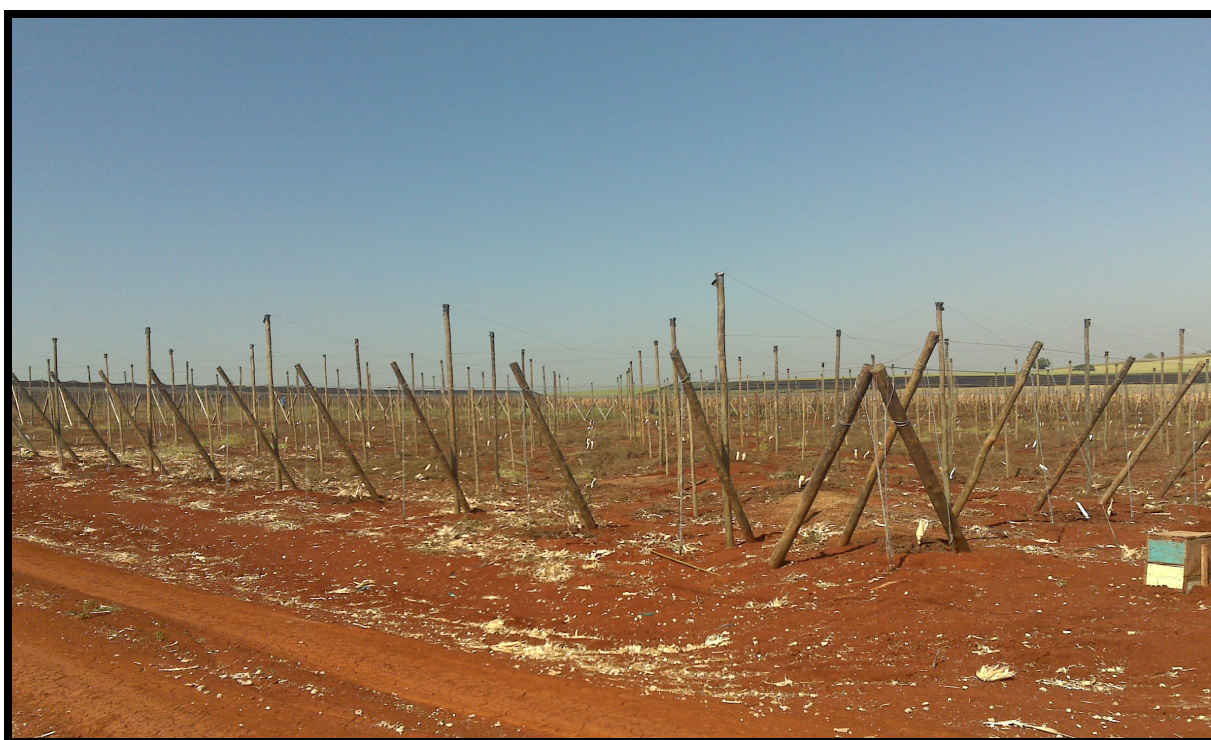
Figura 5 – Montagem da estrutura do parreiral.
