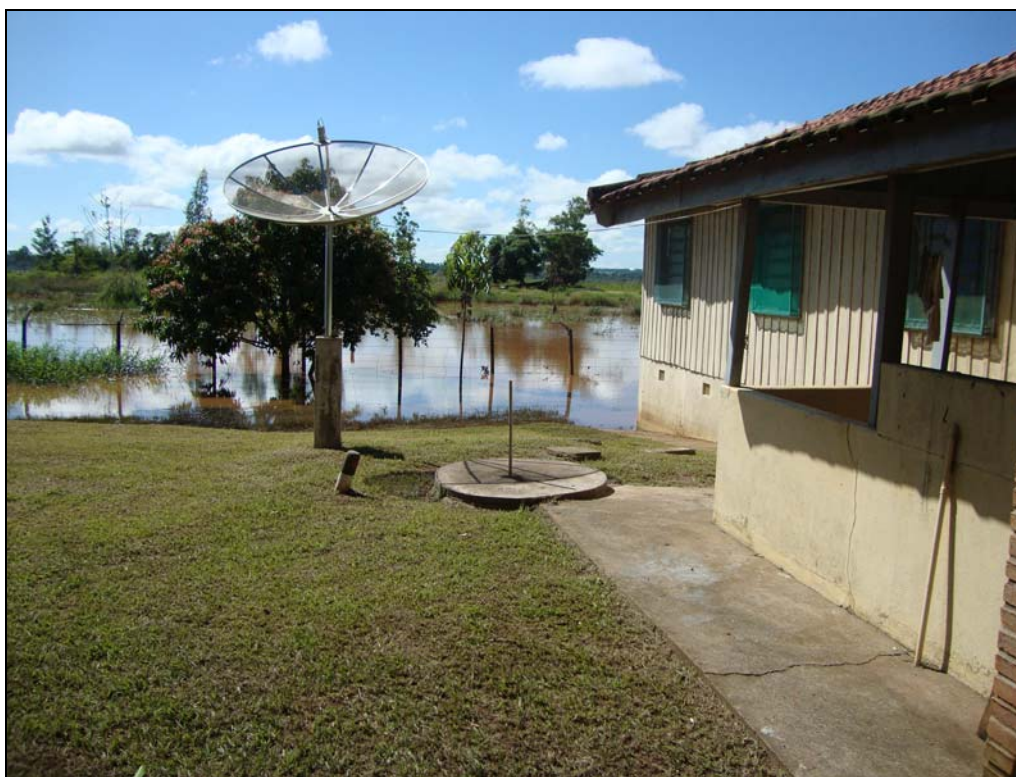
Figura 13. Vista do canal em direção à planície. A casa ao lado direito está sobre o dique marginal e cerca de quatro metros do canal do rio Ivaí. Ao fundo nota-se a bacia de inundação (Unidade III) alagada durante cheia no mês de janeiro de 2010. Foto cedida gentilmente por Sidney Kuerten.
