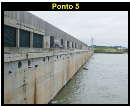
Usina Hidrelétrica Engº. Sérgio Motta
