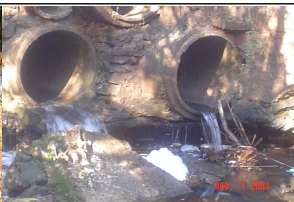
Foto 11 – Lançamento clandestino e irregular de efluentes líquidos sem tratamento no Ribeirão Mandacaru na zona sete, por empresas localizadas nas proximidades da Av. Colombo.
