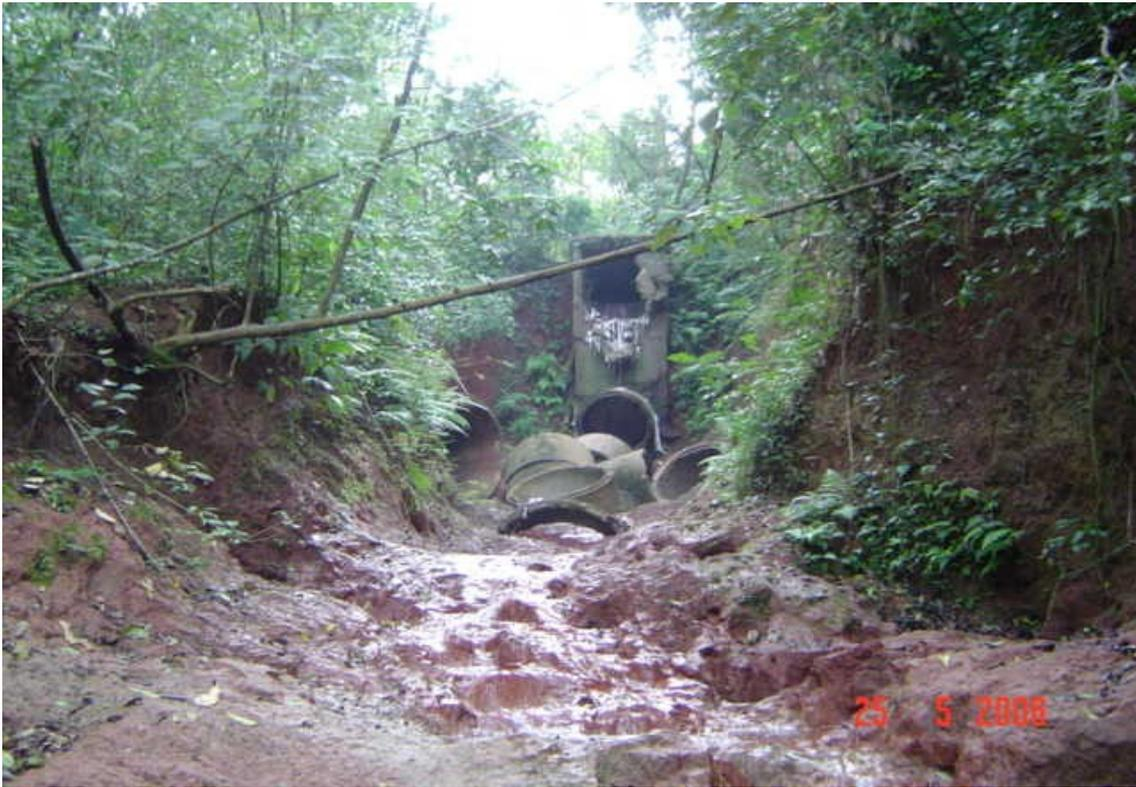
Foto 45 – Tubulações destruídas pela força das águas pluviais no interior do Horto Florestal. Fonte SEMA/2007.
