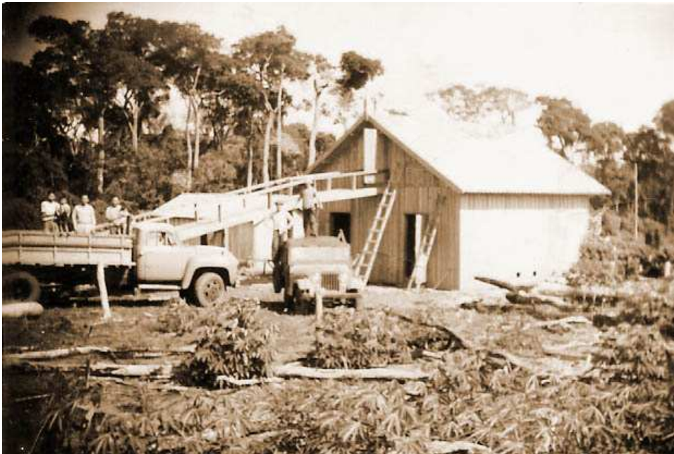
Foto 5 – Construção dos primeiros galpões de estocagem de café, ainda com a presença da mata nativa muito próxima destas estruturas. Fonte Prefeitura Municipal de Itaúna do Sul.
