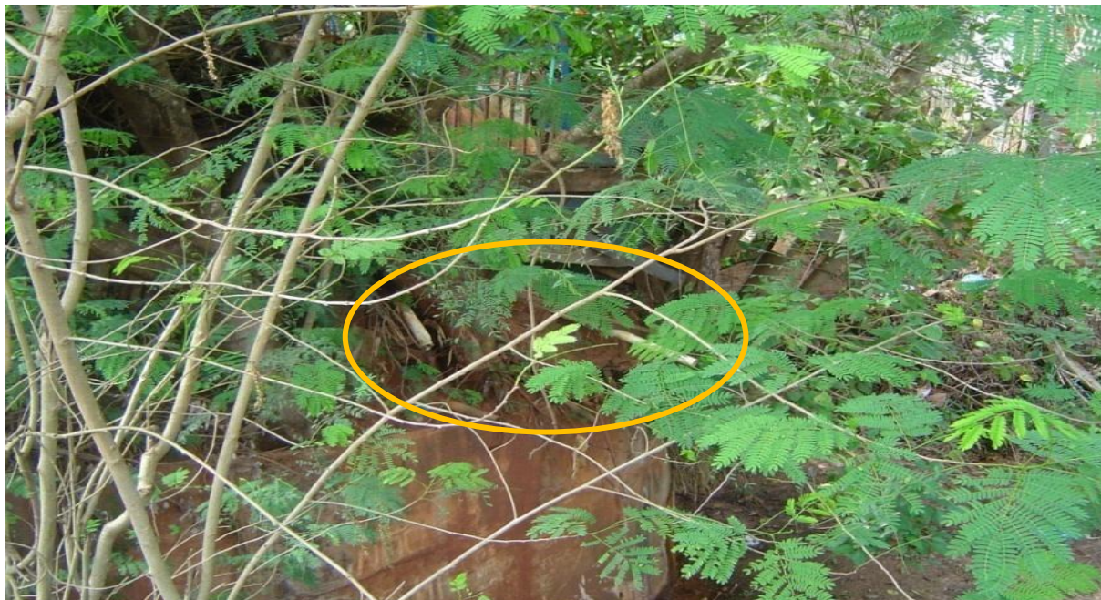
Figura 19 - Tubulação de esgoto nas margens do córrego Pinhalzinho II Autora: VILLA, 2009
