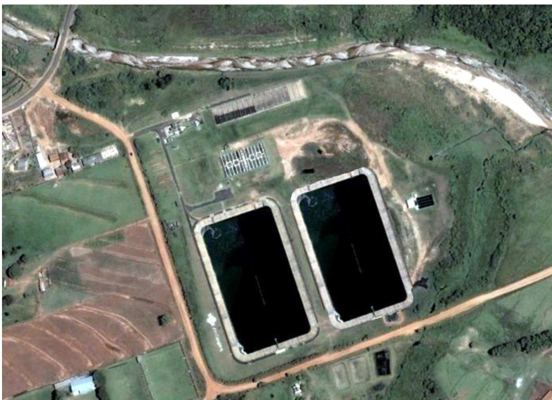
Figura 24 - Estação de Tratamento de Água e Esgoto (SANEPAR - 2005) Fonte: Google Earth (2009)
