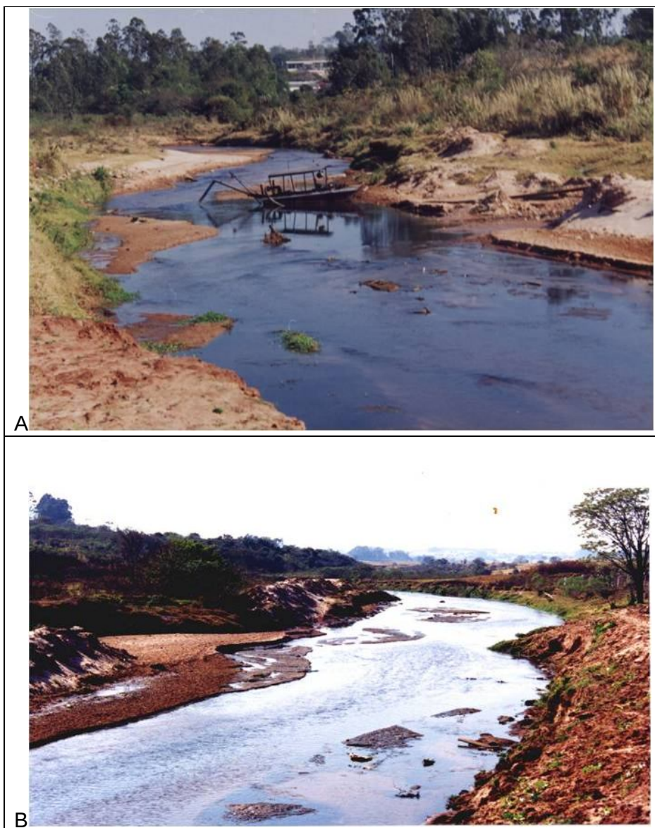
Figura 35 A- Dragagem do canal em 1998 devido a grande quantidade de sedimentos; B- Córrego Pinhalzinho II próximo da área urbana, com processo de assoreamento em 1999
