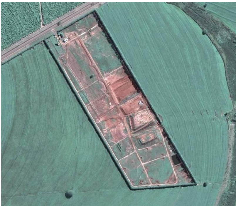
Figura 36: Imagem de Satélite do Aterro Sanitário de Birigui-SP. Fonte: Google Earth (2009).
