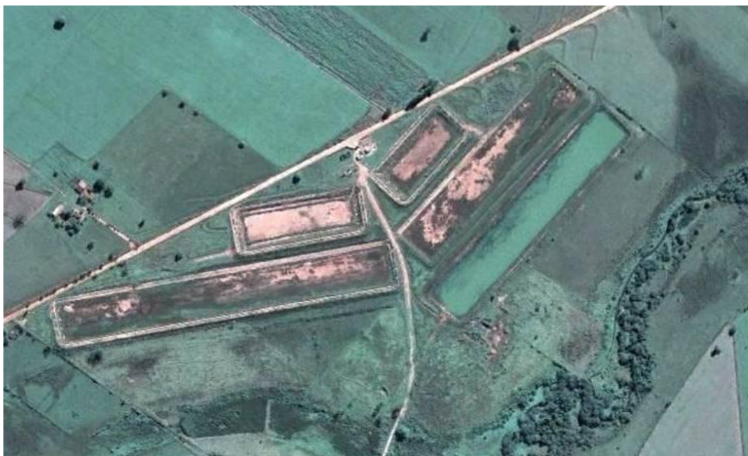
Figura 33: Imagem de Satélite das obras da Estação de Tratamento de Esgoto de Birigui - SP. Fonte: Google Earth (2009).
