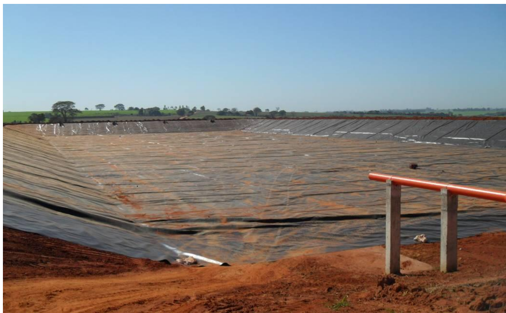
Figura 34: Obras de Construção da Estação de Tratamento de Esgoto de Birigui-SP. Foto: Márcio F. Gomes, 2010.
