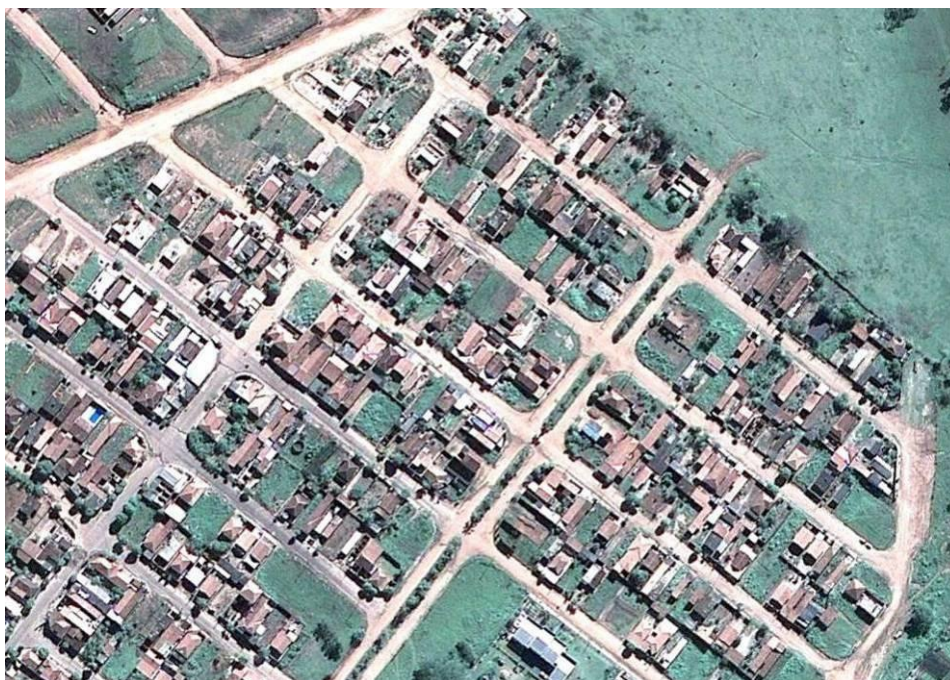
Figura 39: Ausência de Pavimentação Viária, Bairro Quemil – setor censitário 87.
