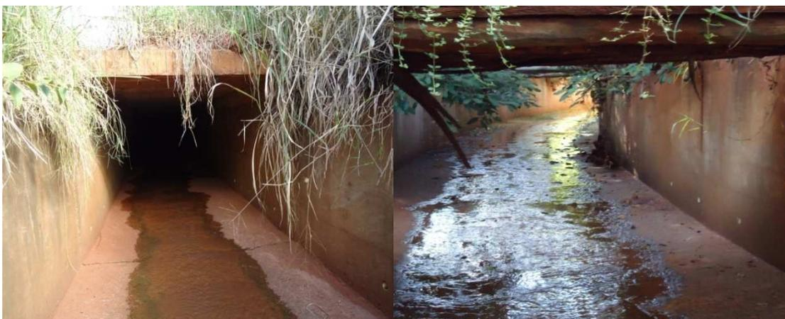
Figura 5.2: Canal de concreto para desvio das águas pluviais no município de Terra Rica (17/02/2011)
