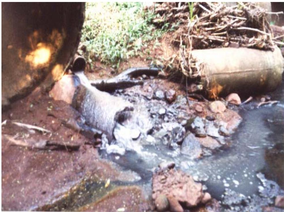
FIGURA 40: Lançamento de resíduos sépticos do esgoto doméstico alternativo efetuado até o 2º semestre de 2004 após tratamento primário, para o ribeirão Borba Gato.
