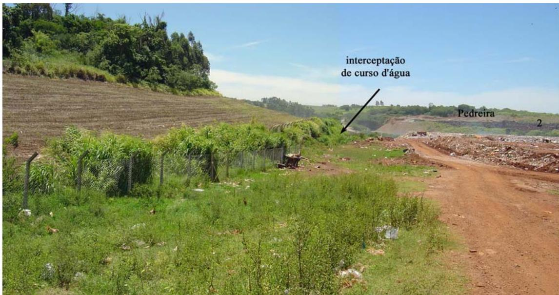
FIGURA 29 - Interceptação do curso d'água no limite da área do depósito de lixo (patamar 2). A divisa corta obliquamente o pequeno vale. Ao fundo vê-se a frente da pedreira em exploração.
