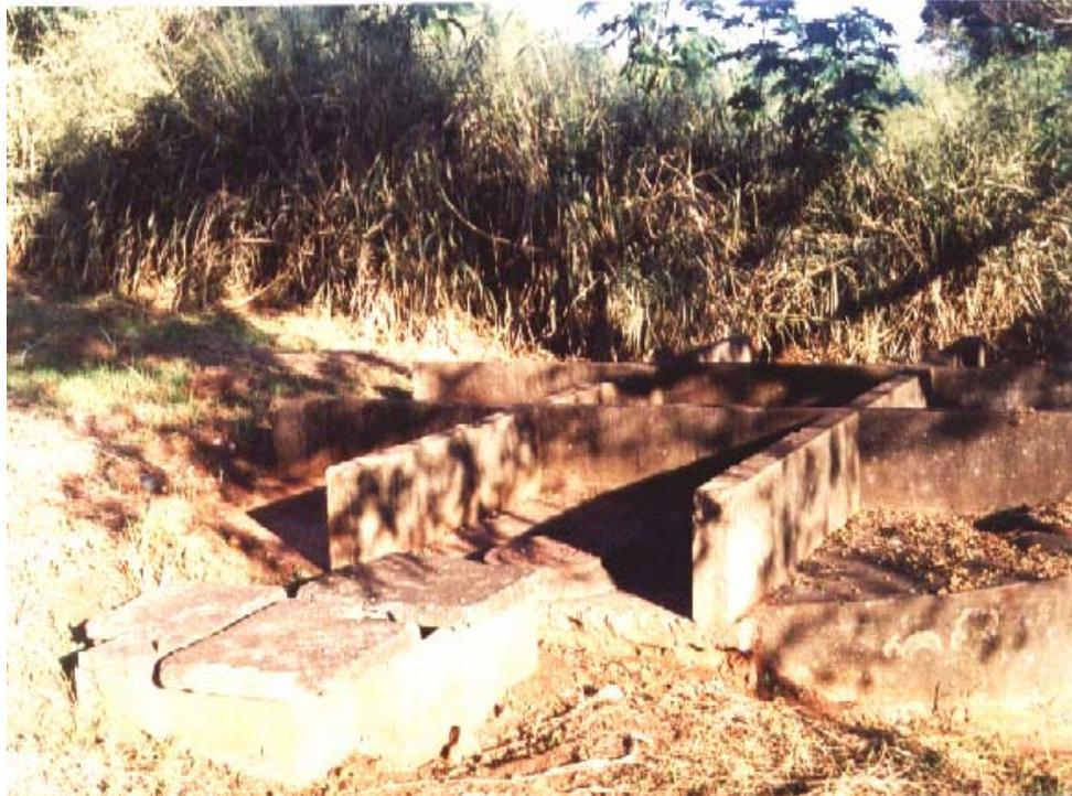
FIGURA 39: Tanque séptico para tratamento primário do esgoto alternativo.
