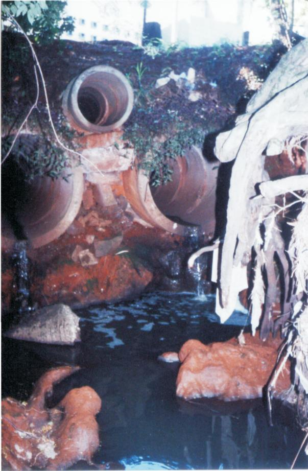
FIGURA 35: Tubulação de descarga de galerias pluviais dentro do Horto Florestal e lixo nas raízes expostas.
