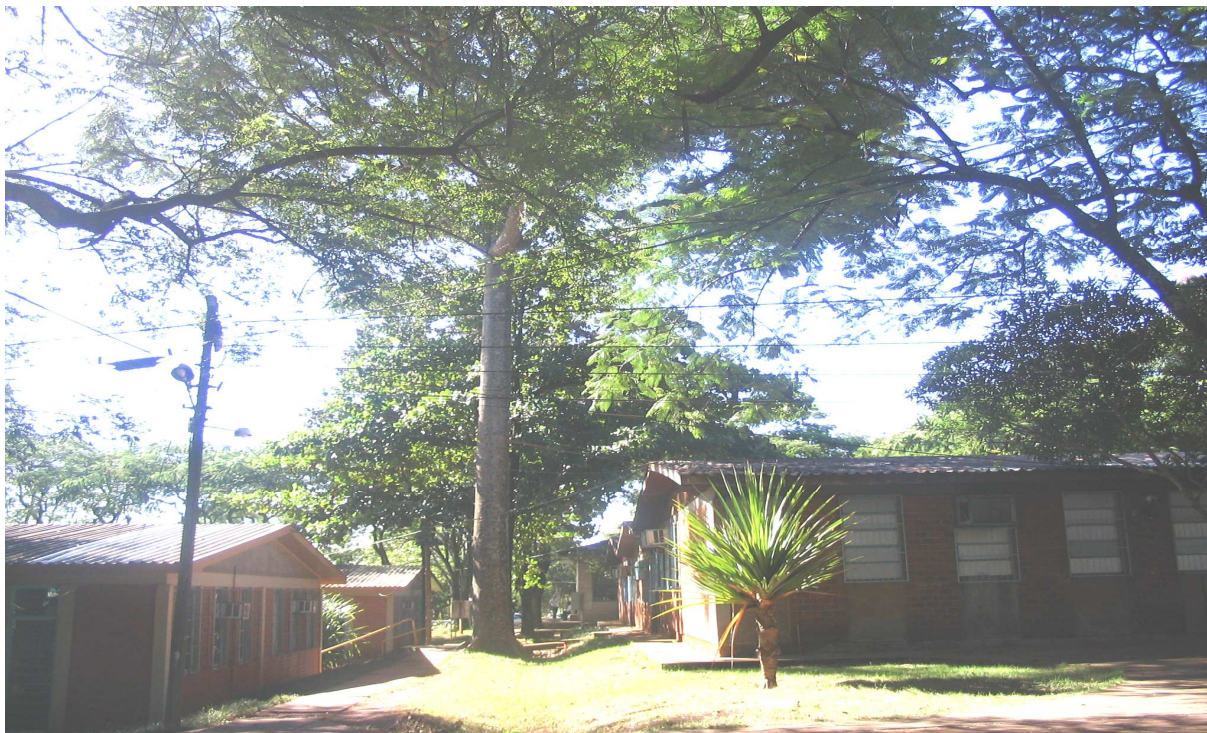
Foto 12 – Guapuruvu ( Shizolobium parahyba ) muito próxima da edificação, localizada na face oeste do bloco 19.
