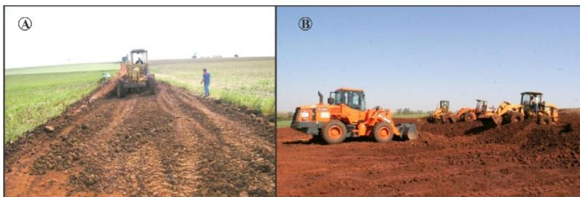
Figura 14 – A) Cascalhamento da estrada R5; B) Readequação da Estrada Marfim.
