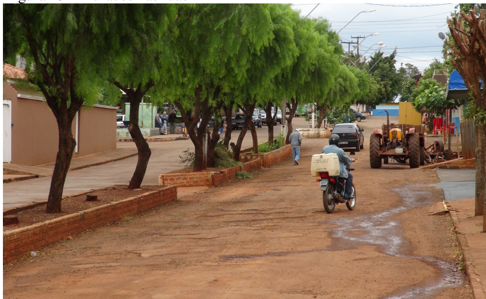
Figura 15 - Buracos nas ruas
