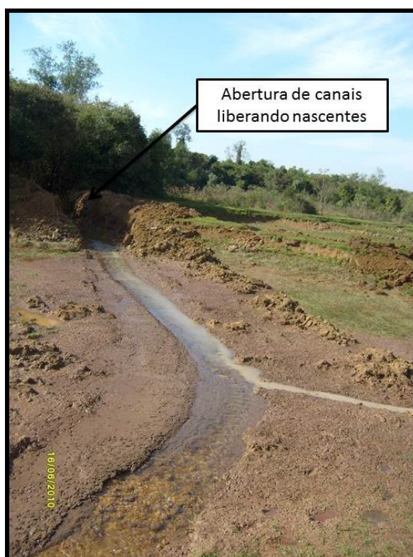
Foto 27 – Abertura de canal para liberação do fluxo de água em nascentes na microbacia Progresso
