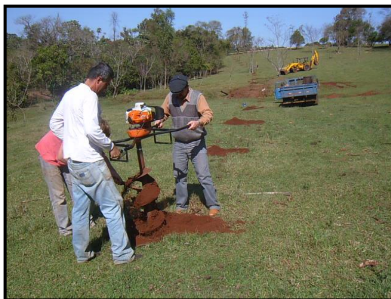
Fonte: Secretaria Municipal de Agricultura e Meio Ambiente de Mercedes. Foto 18 – Escavação para fixação de mourões na microbacia Sanga Mineira
