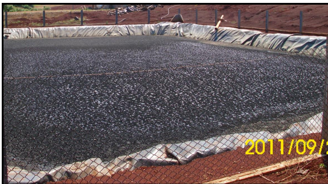
Fonte: Dalésio Ostrovski (2011). Foto 52 – Tanque coletor de dejetos de suínos
