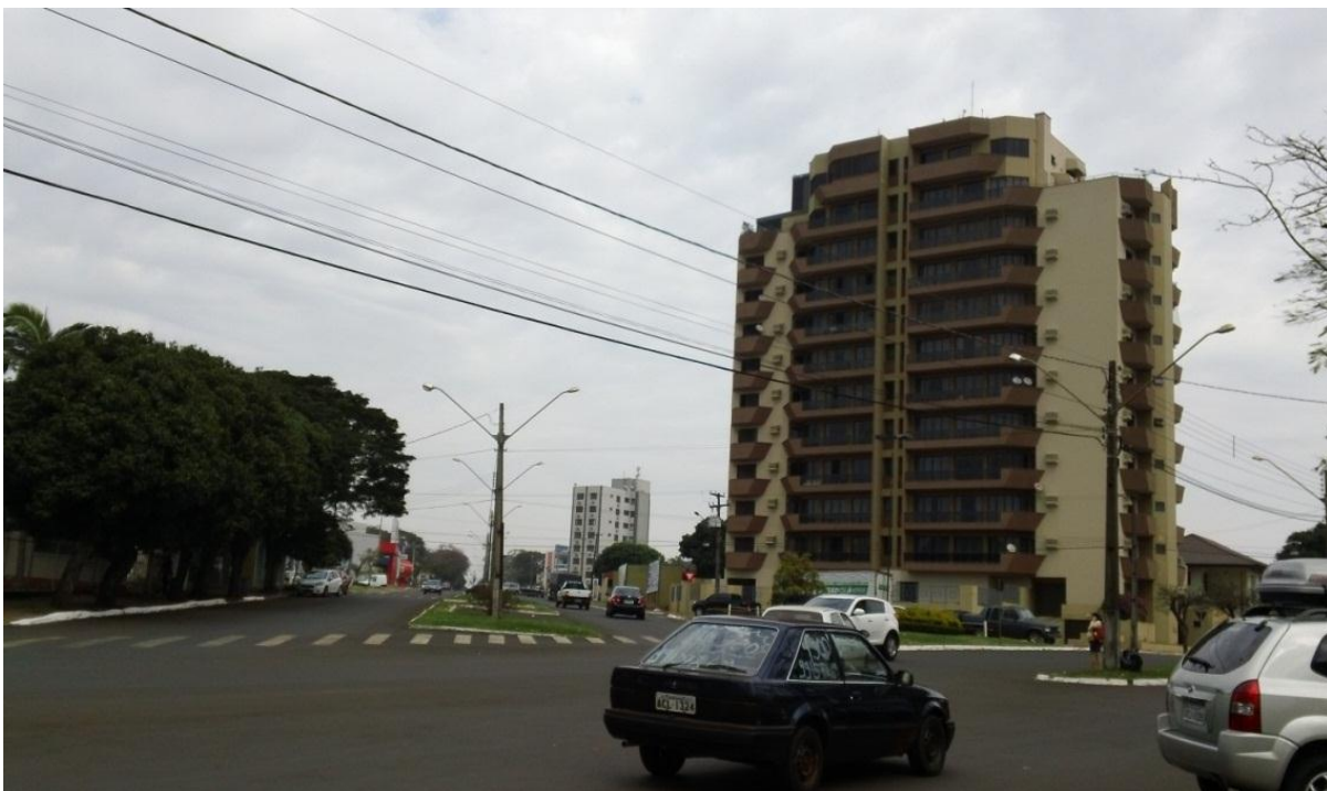
Figura 16: Edifício Campos Dourados. Avenida José Calegari cruzamento com a Rua Argentina - Medianeira.
