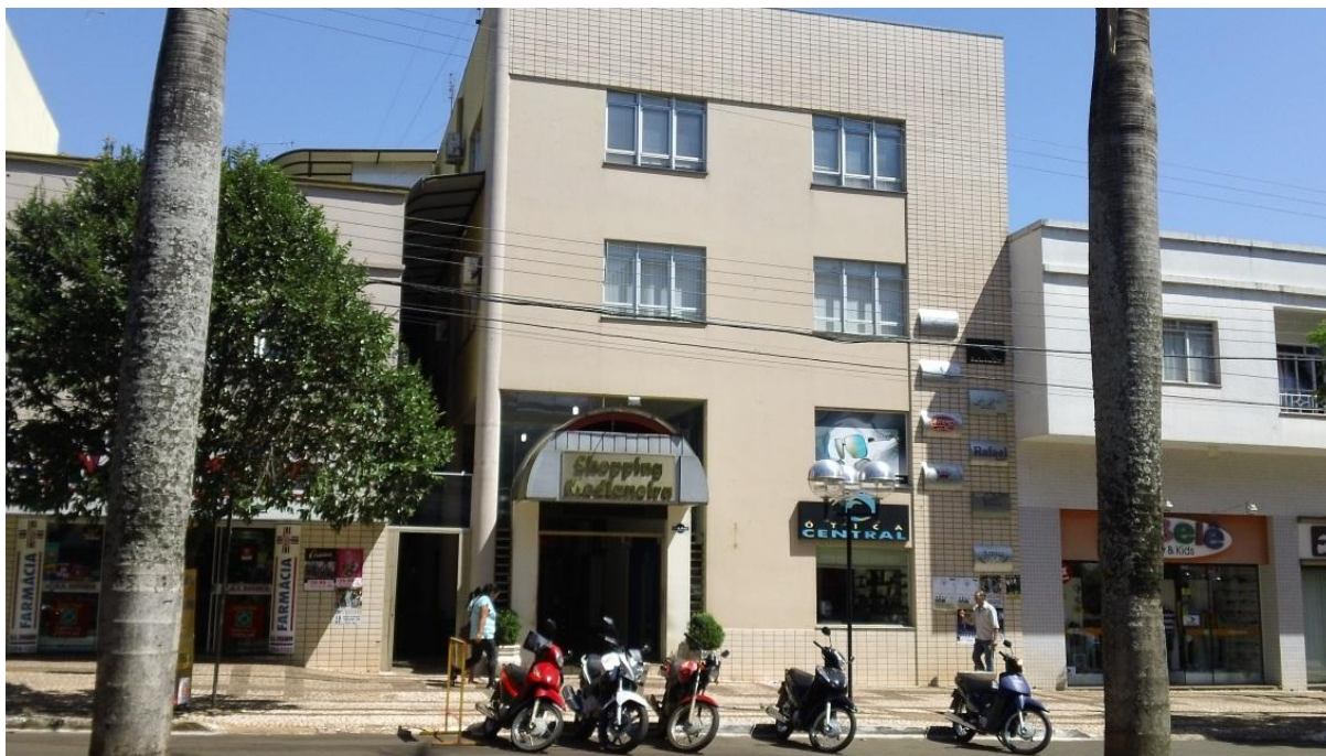
Figura 19: Shopping Medianeira – Avenida Brasília.
