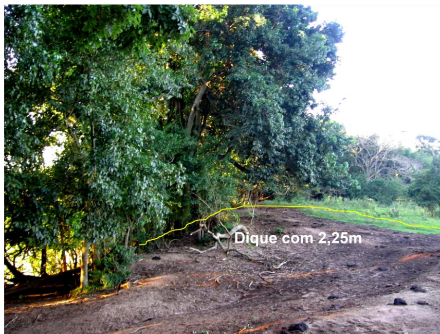
Figura 26: Dique marginal da margem esquerda do rio Ivaí, localizado nas coordenadas 23°11'25"S 053°31'25"W. Notar em primeiro plano, a erosão provocada pelo pisoteio do gado bovino. Fonte: Douhi, N. (2011).
