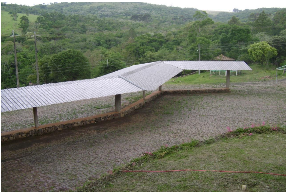
FIGURA 83 – Abrigo para carros – Pousada Caminho das Águas Mansas em São Jerônimo da Serra FONTE: Pesquisa de campo, 2014.
