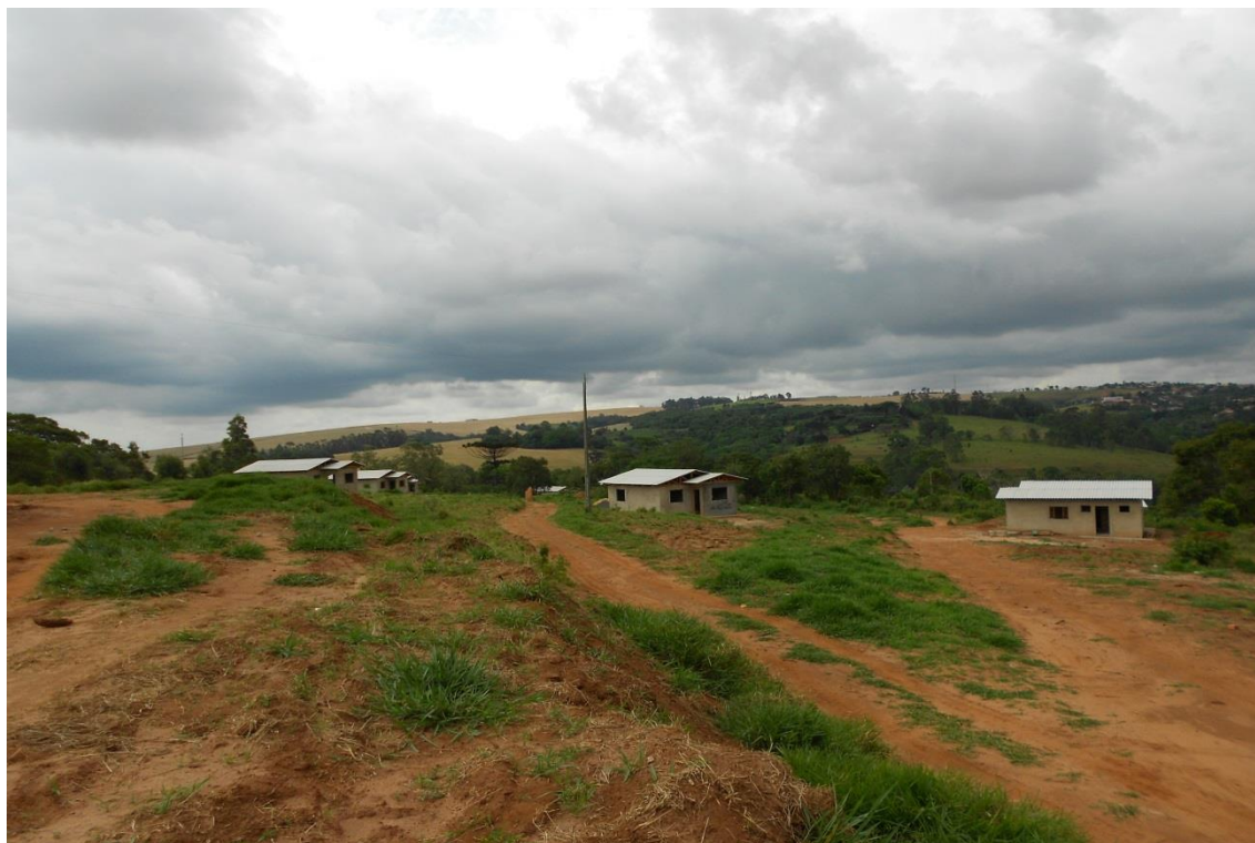
FIGURA 97 – Novas habitações construídas na Terra Indígena São Jerônimo FONTE: Pesquisa de campo, 2014.
