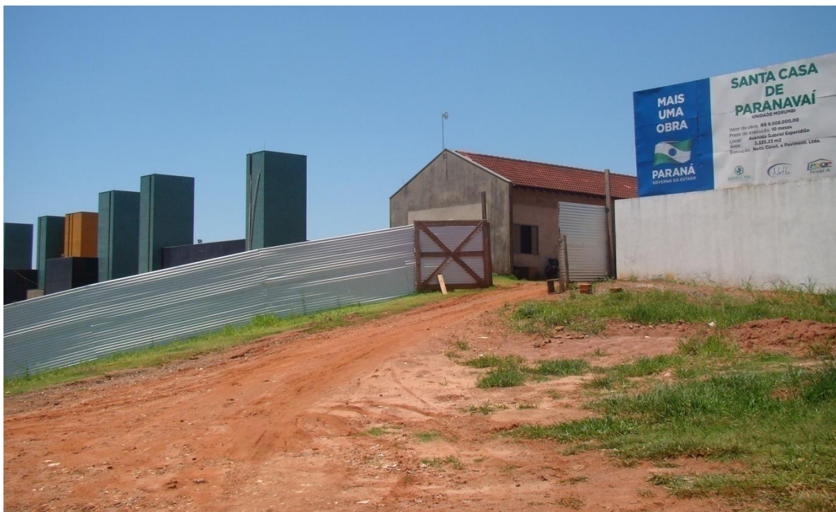
Figura 20: Vista parcial do prédio onde será o Hospital Santa Casa, sede II em Paranavaí-Pr, 2015.
