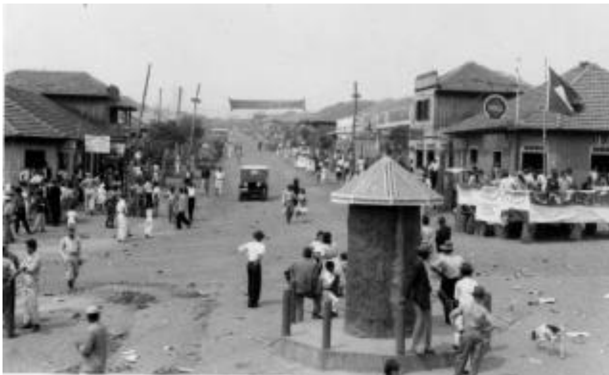
Figura 8: Dia de comício, 1955, Avenida 14 de Dezembro, à esquerda Bar Central e a direita Bar Avenida. Nova Esperança- PR, 1955.
