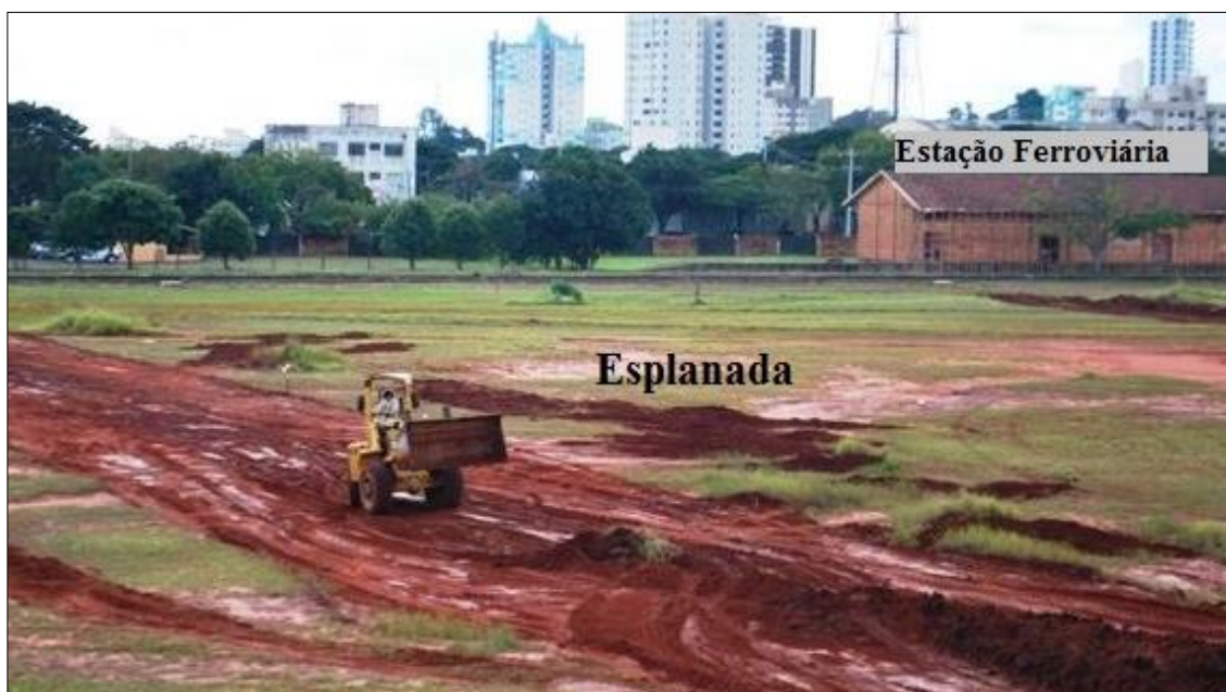
Figura: 30 – Início das obras de infraestrutura do Novo Centro
