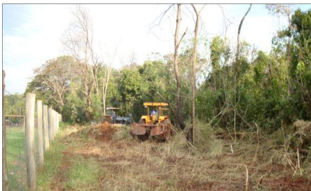
Figura 49: Retirada de vegetação rasteira (capim coloniã e samambaia) do PCVC com uso de máquina pesada
