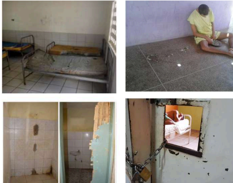
Figura 10 - Imagens recentes do relatório de inspeção “Hospitais Psiquiátricos no Brasil”.
